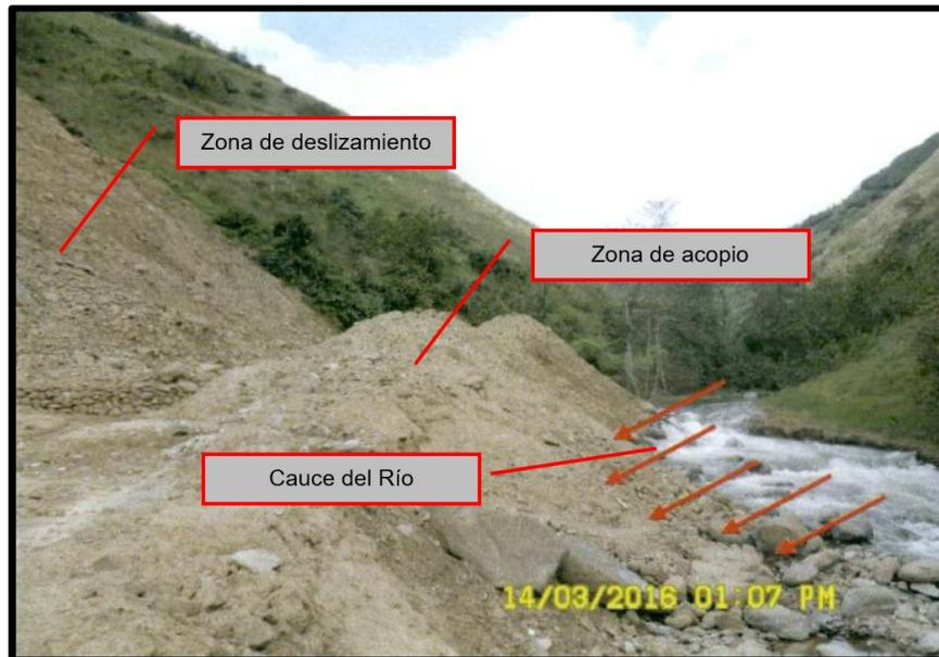
**Fotografía H01-4 del Informe de Supervisión:** Vista de la zona de derrumbe, en la cual se observa que el administrado ha dispuesto el desmonte en la ladera colindante y en parte del cauce del río
