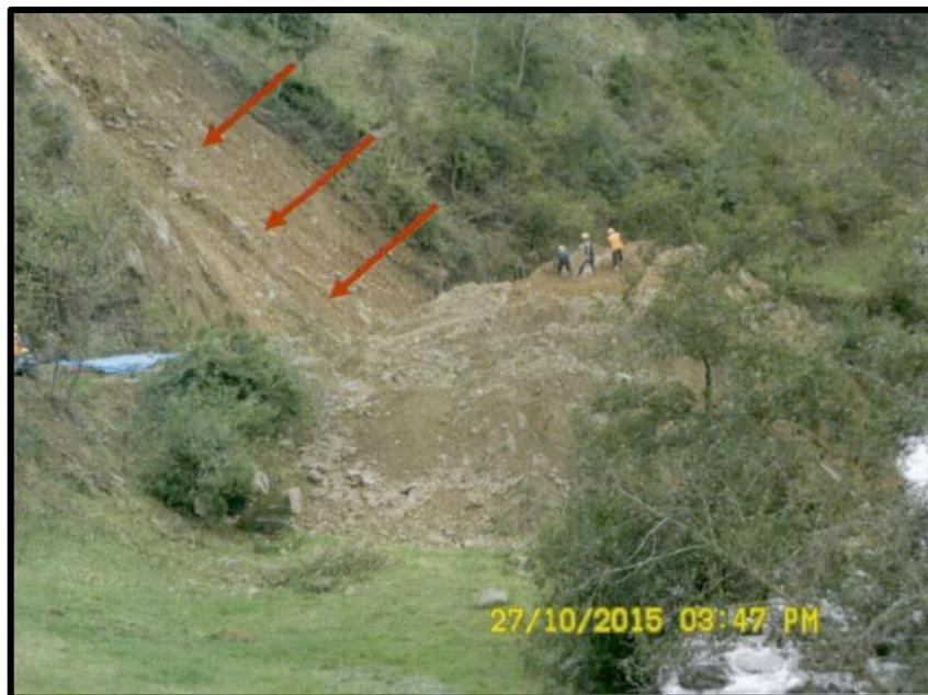
**Fotografía H01-2.** Fotografía tomada en la supervisión de 27 de octubre de 2015, en esta se puede ver la ladera del cerro que se ha desprendido sobre el canal de conducción.
