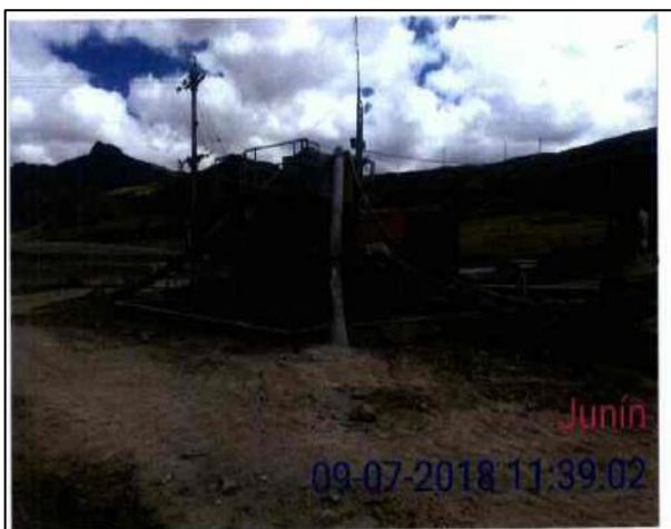
Foto N°5: Área alrededor de la zona de cicloneo de relaves en las coordenadas WGS84 18L 8714769 N y 386139 E
