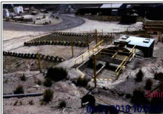
Foto N°1: Zona alrededor de la trampa de aceites y grasas general, en las coordenadas WGS84 18L 8703420 N y 383324 E
