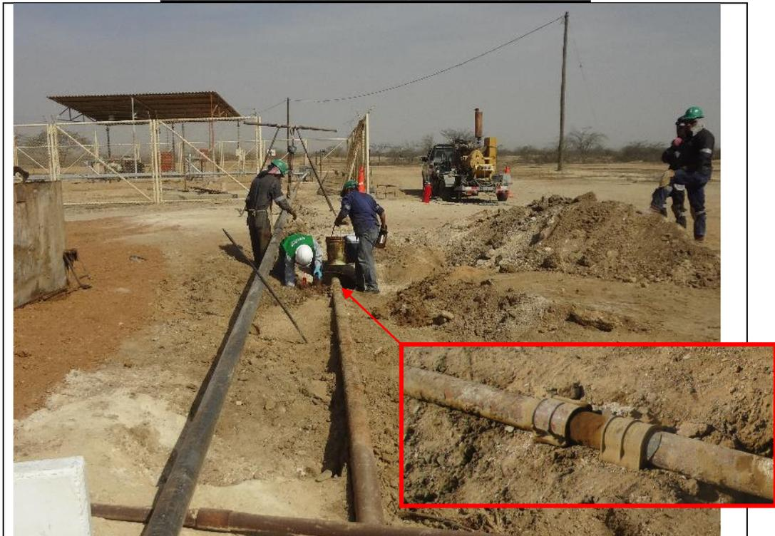
Se observa Oleoducto 4" OLB – LA-09 tramo 2, en el que se aprecian: - que el tramo que estuvo enterrado presenta corrosión y deterioro del material metálico, a diferencia del tramo que no estuvo enterrado, (...).
