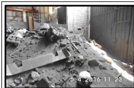
**Foto N° 12:** Se observa que este desmonte no cuenta con ningún sistema de contención para su almacenamiento, el portón da hacia el exterior del establecimiento.
