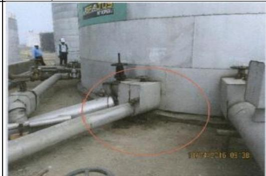
**Foto N° 80:** En la fotografía se observa, la presencia de suelos impregnados con hidrocarburo (Asfalto), ubicados en la parte baja de las válvulas de recepción, despacho y mezclado del Tanque N° 33. Se tiene un área impactada con suelos impregnados con hidrocarburos de aproximadamente 3.0 m<sup>2</sup> (3.00 m x 1.00 m), 0.50 m<sup>2</sup> (1.00 m x 0.50 m), y 9 m<sup>2</sup> (3.00 m x 3.00 m).
