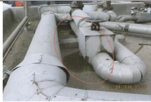
**Foto N° 79:** En la fotografía se observa, la presencia de suelos impregnados con hidrocarburo (Asfalto), ubicados en la parte baja de las válvulas de recepción, despacho y mezclado del Tanque N° 33. Se tiene un área impactada con suelos impregnados con hidrocarburos de aproximadamente 3.0 m<sup>2</sup> (3.00 m x 1.00 m), 0.50 m<sup>2</sup> (1.00 m x 0.50 m) y 9 m<sup>2</sup> (3.00 x 3.00 m).
