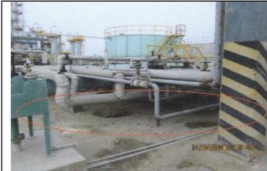
**Foto N° 77:** En la fotografía se observa, la presencia de suelos impregnados con hidrocarburo, ubicados en la parte baja del rack de tuberías, en la línea de Gasóleo Pesado, que se encuentra al este de los Tanques N° 62 y 63 de la Refinería Conchán. Se tiene un área impactada con suelos impregnados con hidrocarburos de aproximadamente 4.0 m<sup>2</sup> (2.0 m x 2.0 m).
