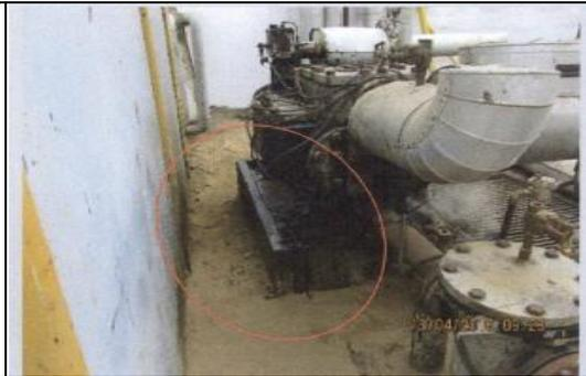
**Foto N° 78:** En la fotografía se observa, la presencia de suelos impregnados con hidrocarburo (Asfalto), ubicados a los alrededores de las losas en que se encuentran colocados las bombas de despacho de Asfalto, correspondientes a los tanques N° 36 y 72. Se tiene un área impactada con suelos impregnados con hidrocarburos de aproximadamente 0.250 m<sup>2</sup> (0.50 m x 0.50 m).
