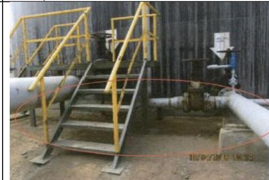
**Foto N° 82:** En la fotografía se observa, la presencia de suelos impregnados con hidrocarburo (Asfalto Residual), ubicados en la parte baja de la válvula de recepción, aliado norte del Tanque N° 7. Se tiene un área impactada con suelos impregnados con hidrocarburos de aproximadamente 7.50 m<sup>2</sup> (5.00 m x 1.50 m).
