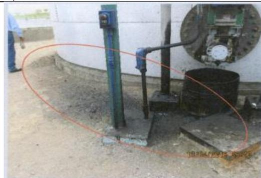
**Foto N° 81:** En zona adyacente al Pozo AA6889 (ATA) se evidenció suelo impregnado con hidrocarburos, en un área aproximada de 5.5 m<sup>2</sup> y 0.15 m de profundidad, adicionalmente se observó 2 manchas de suelo impregnado con hidrocarburos en un área conjunta aproximada de 0.18 m<sup>2</sup> y 0.05 m de profundidad. Coordenadas UTM-WGS 84: 0485300 E. 9522967 N.
