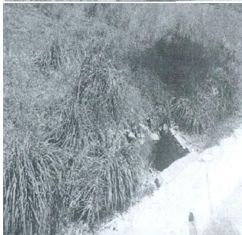
Fotografía N° 21: Vista de la segunda zona, ubicado en coordenadas UTM (WGS 84), E: 766695, N: 9253265, donde se identificó el geotextil expuesto al ambiente. Además se observa, la tubería del drenaje de agua sub superficial.
