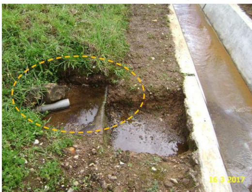
Fotografía N° 21: Vista de la segunda zona, ubicado en coordenadas UTM (WGS 84), E: 766695, N: 9253265, donde se identificó el geotextil expuesto al ambiente. Además se observa, la tubería del drenaje de agua sub superficial.
