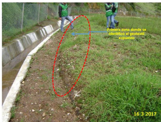
Fotografía N° 15: Vista del borde de la plataforma superior del depósito de relave N° 5, adyacente al canal de coronación, donde se observó que el geotextil se encontraba expuesto al ambiente, con deterioro de la cobertura vegetal.
