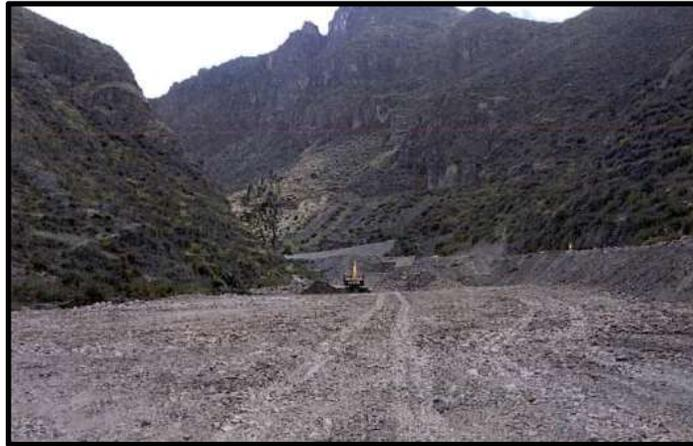
**Imagen N° 4:** Nivelación y conformación de la Cantera de Carampoma y chancadora
