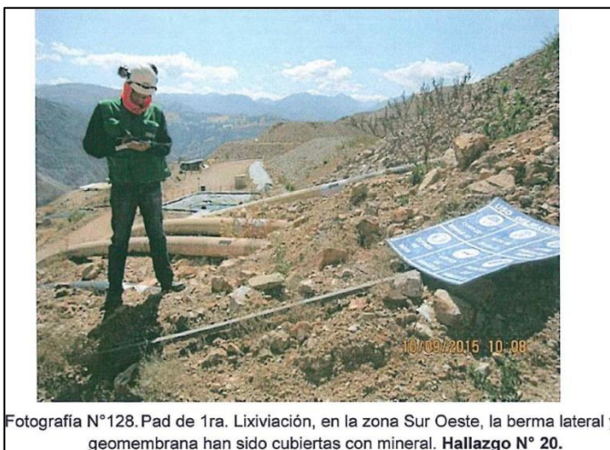
Fotografía N°127. Pad de 1ra. Lixiviación, en la zona Sur Oeste, la berm lateral y geomembrana han sido cubiertas con mineral. Hallazgo N° 20.
