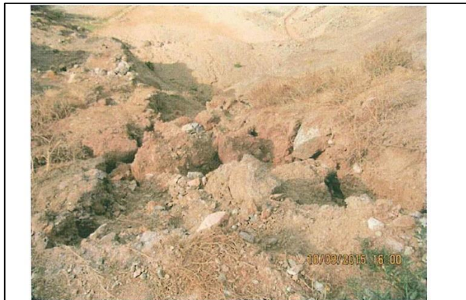
Fotografía N°135. El canal de derivación de aguas de escorrentía del Pad de rípios y Planta Merrill Crowe, a provocado erosiones en el suelo en su descarga. Hallazgo N° 21.
