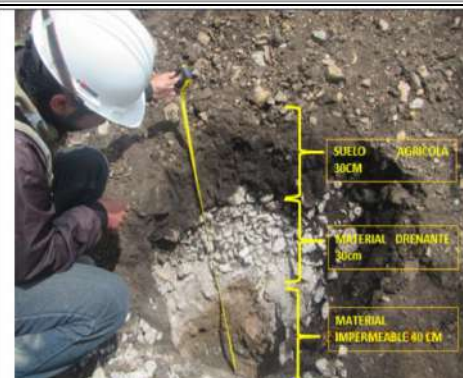
FOTOGRAFIA N° 06.- Vista en donde se identifica las capas establecidas para la Desmontera DA-15, se constató tres diferentes capas.
