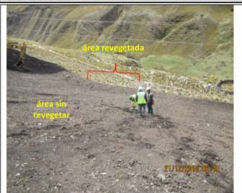
FOTOGRAFIA N° 05.- Se observa el área revegetada y el área sin revegetar en la Desmontera DA-15.
