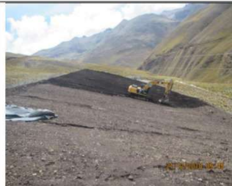
FOTOGRAFIA N° 04.- Vista en donde se observa el trabajo de maquinaria pesada (conformación de la capa de suelo agrícola) en el talud de la Desmontera DA-15.
