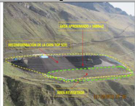
FOTOGRAFIA N° 03.- Vista panorámica de la Desmontera DA-15, se observa que la parte inferior se encuentra revegetada y la parte superior está sin revegetar. Ubicada en la coordenada UTM WGS84 8 559 540N 504 560E.
