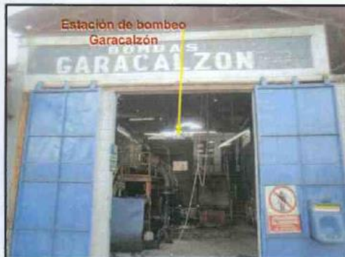
Fotografía N° 24: Vista panorámica de la Planta de bombeo Garacalzon, ubicada adyacente a la planta de neutralización de la unidad minera Cerro de Pasco, con coordenadas UTM WGS 84 N 8 818 810 E 360 646.
