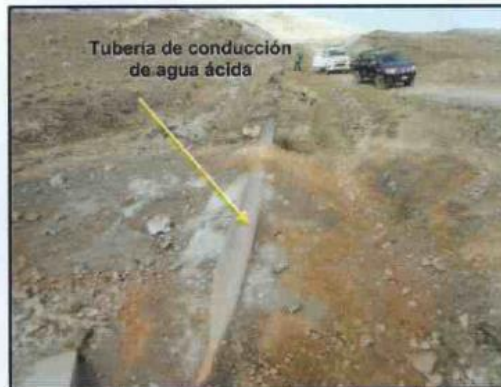
Fotografía N° 22: Ubicado en el cruce de la tubería con la antigua carretera de acceso a la ciudad de Cerro de Pasco.
