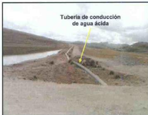
Fotografía N° 21: Vista panorámica de la tubería de conducción de agua ácida hacia la laguna Yanamate, con coordenadas UTM WGS 84 N 8 816 323 E 362 116.
