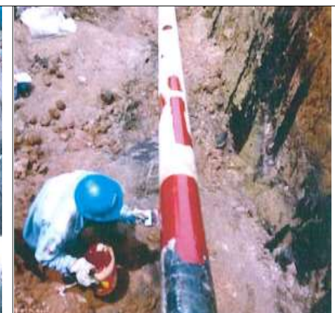
Vista fotográfica del proceso de resane del recubrimiento.
