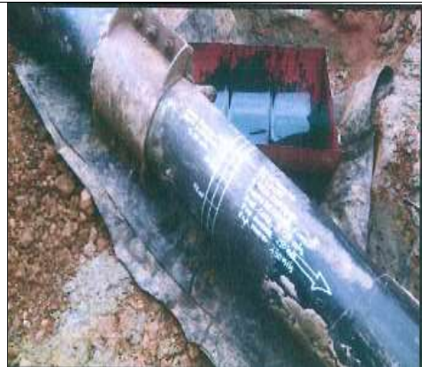
Vista fotográfica de la grapa hot tap instalada.
