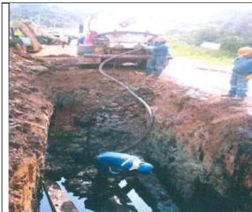
Vista fotográfica proceso de drenado del crudo remanente existente en el interior del tramo a reemplazar.
