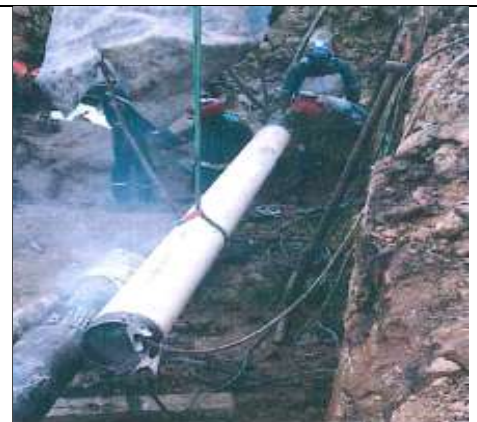
Vista fotográfica del proceso de soldeo de juntas.
