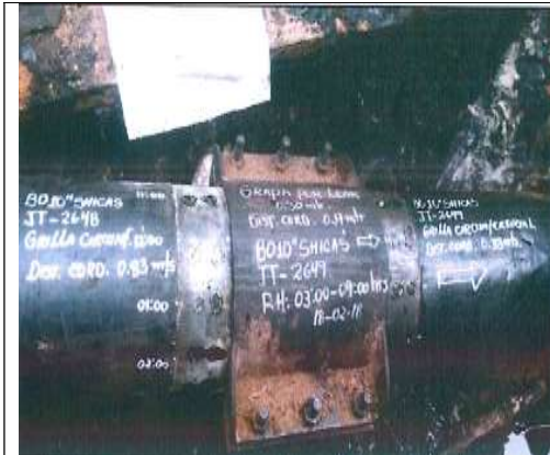
Vista fotográfica del trabajo de medición de espesores realizado en los laterales de la grapa correctiva instalada.
