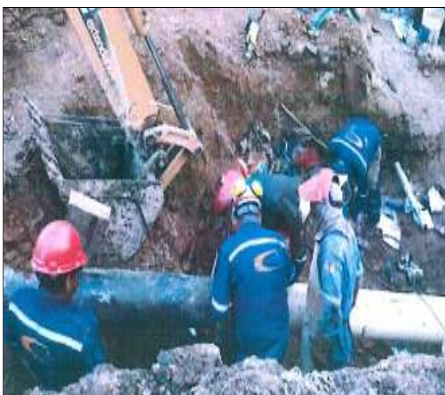
Vista del inspector en proceso de inspección visual del cordón de soldadura.
