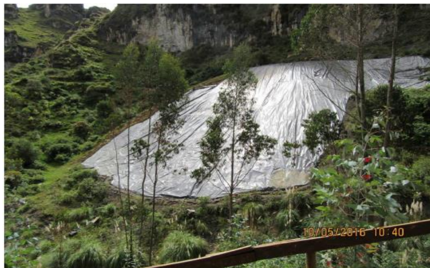
Fotografía N° 83: Depósito de carbón recubierto con geomembrana, en el sector de Pucará, ubicado en el margen derecho de la quebrada Pucará. Coordenadas UTM WGS84 8839844N; 344034E.
