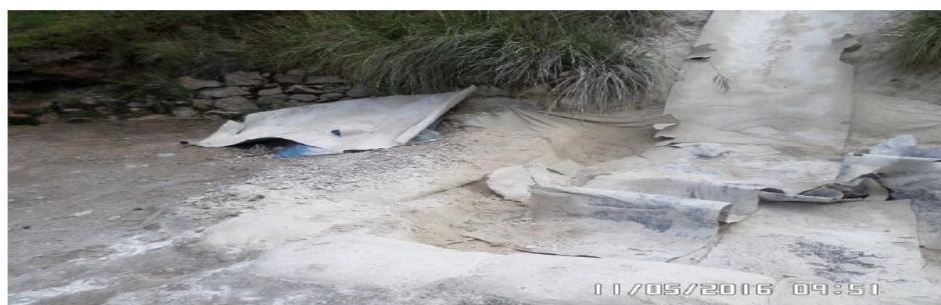
Fotografía N° 7: Vista frontal del canal con geomembrana, por donde se transportaría los sacos con cal, en cuya parte final de llegada se observa restos de cal sobre el suelo.
