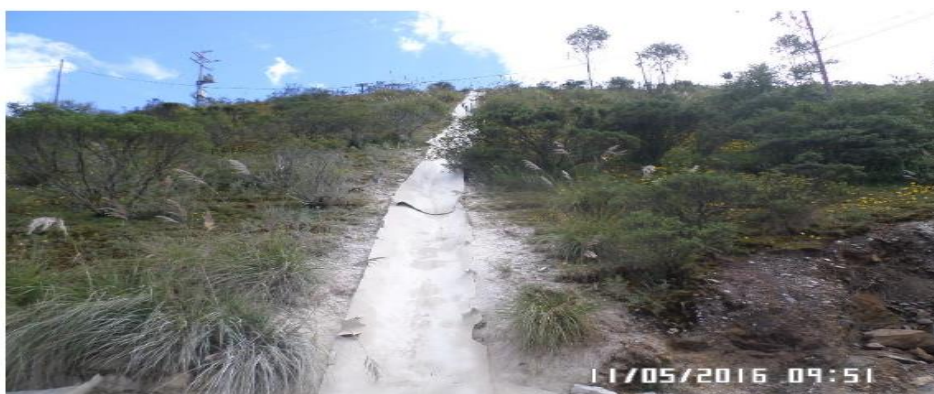
Fotografía N° 5: Vista frontal del canal con geomembrana, por donde se transportaría los sacos con cal en cuyos lados se observan restos de cal sobre el suelo.
