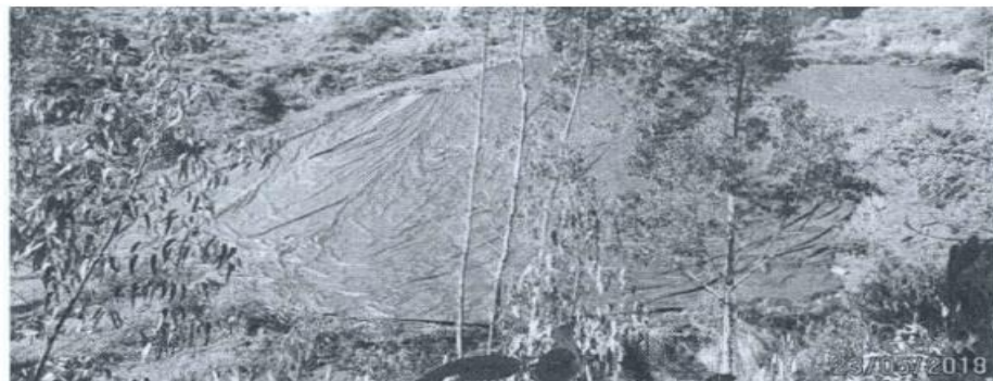
Fotografía N° 1: Se observa las condiciones actuales (23.05.2018) del botadero de carbón; recubierto totalmente con geo membrana para impedir el ingreso de agua y oxígeno.
