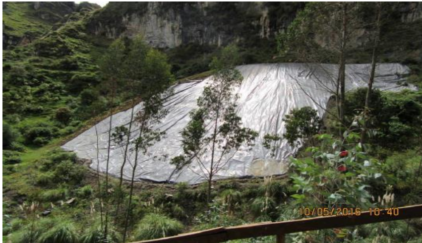
Fotografía N° 82: Depósito de carbón recubierto con geomembrana, en el sector de Pucará, ubicado en el margen derecho de la quebrada Pucará. Coordenadas UTM WGS84 8839844N; 344034E.
