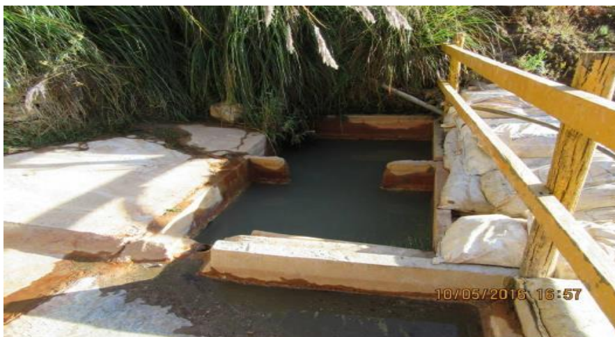
Fotografía N° 51: Poza de concreto rectangular con agua en su interior, así como tuberías de ingreso y salida cuyas aguas estarían siendo descargadas a la quebrada Puyush.
