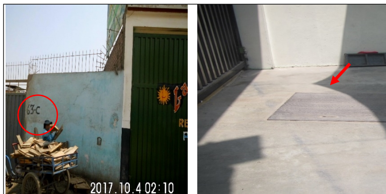
Fotografía N° 21: Vista de pozo de agua subterránea (pozo), corresponde a las coordenadas señaladas en el Informe N° 925-2014-PRODUCE-I/DIGGAM-DIEVAI, en donde se establece como compromiso realizar monitoreo de agua subterránea en este punto. Se observa que el pozo se encuentra clausurado cuenta con una tapa de metal y según lo señalado por el dueño este pozo se rellenó con tierra antes de colocarle esta tapa; el pozo se encuentra ubicado en la vivienda de la Mz 63 Lote C de la calle los Rosales.
