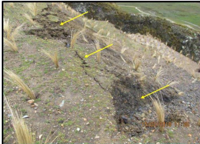
Fotografía N° 298: La superficie del depósito de desmonte se encontraba perfilado en cuatro (4) banquetas y revegetada. En la parte alta del talud de la cuarta banqueta, se observó que había huellas de inestabilidad física y erosión hídrica. En la superficie de las banquetas no se habían construido estructuras hidráulicas para la colección y derivación de la escorrentía.
