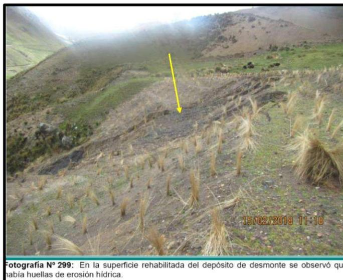
Fotografía N° 299: En la superficie rehabilitada del depósito de desmonte se observó que había huellas de erosión hídrica.
