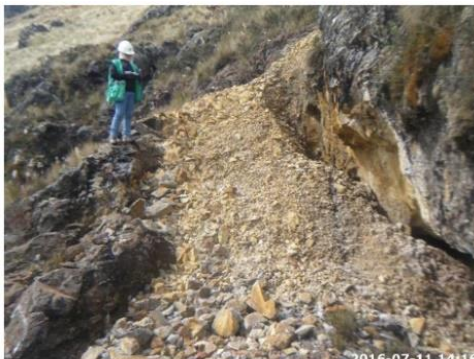
Fotografía N° 374: Hallazgo 9: Se observó que el depósito de desmonte DD CHCJ-7, no ha sido revegetado.
