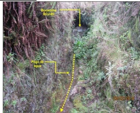
Fotografía N° 436: Bocamina BCJ-65. Ubicada en el Sector 9: Mina Cerro Jesús, con coordenadas UTM WGS 84 - Zona 17: N 9252620; E 763952, donde se observa vegetación en su entorno exterior. Asimismo, un canal de suelo compactado que deriva un flujo de agua desde el portal de la Bocamina hacia la dirección de la vía de acceso.
