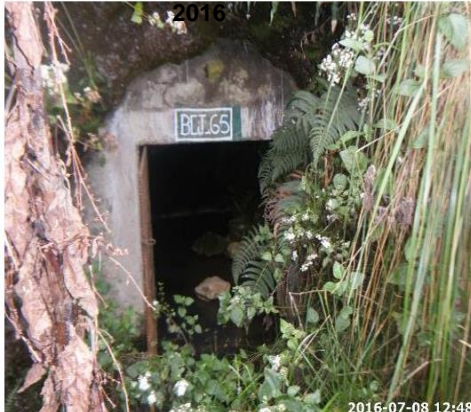
Fotografía N° 368: Hallazgo 6: Se observó que las bocaminas BCJ-65 no ha sido rellenada con material de desmonte ni revegetada.
