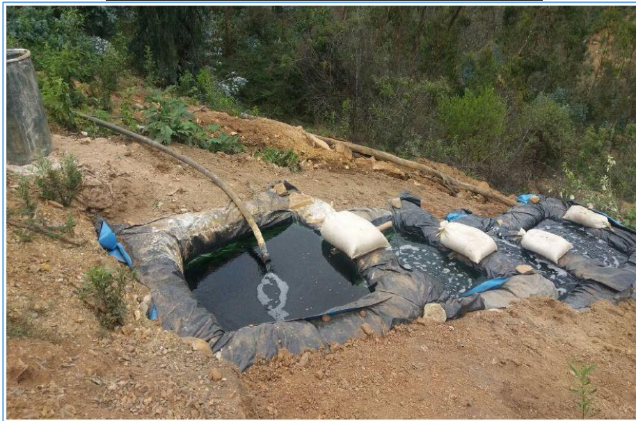
Sistema de Tratamiento Provisional con lechada de cal
