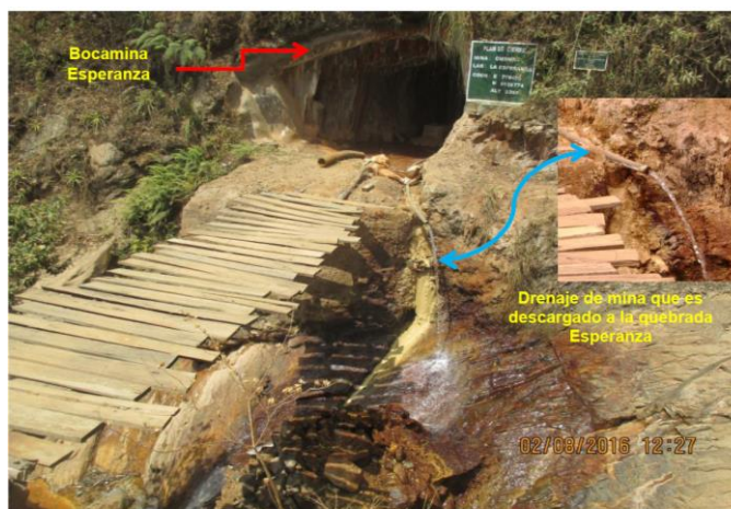
Fotografía N° 9: Otra vista de la descarga del drenaje de la bocamina Esperanza hacia la quebrada del mismo nombre.
