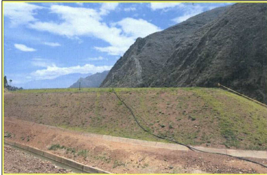
Riego por aspersión controlado en plataforma relavera.
