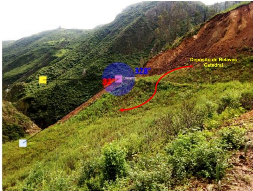
Fotografía N° 3: Vista de perfil del depósito de relaves Catedral en el que se muestra la pendiente.
