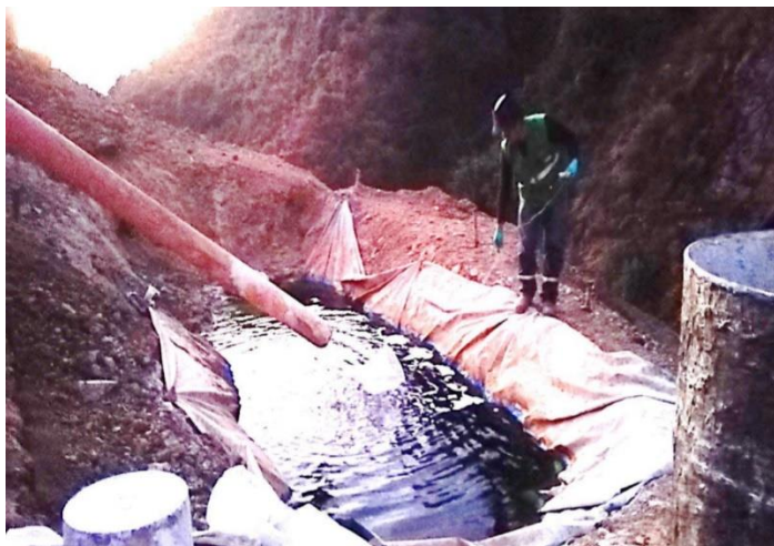
Fotografía N° 148: Toma de muestra en el punto ESP-1- Agua de la poza de tratamiento manual del subdrenaje de la relavera Vista Bella, con coordenadas (UTM WGS-84), E 778969 N 9160117.
