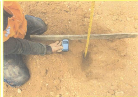
Foto 48. Vista donde se aprecia el control del espesor de material de baja permeabilidad.
