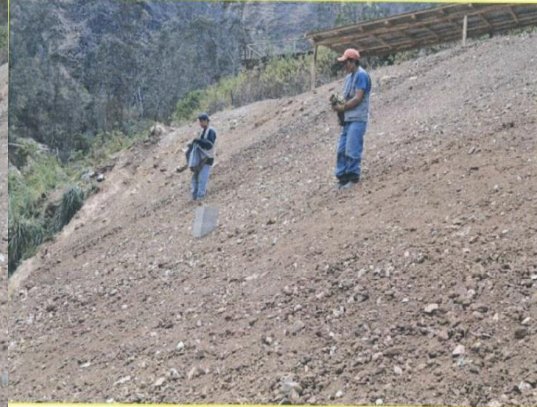
Siembra de chocho en los taludes de la desmontera.
