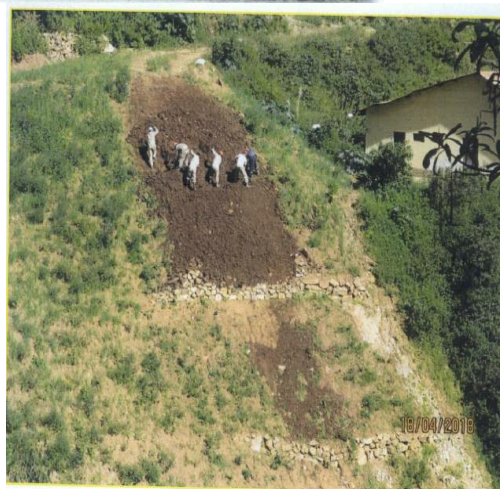
Perfilado de talud para mejoramiento del terreno.
