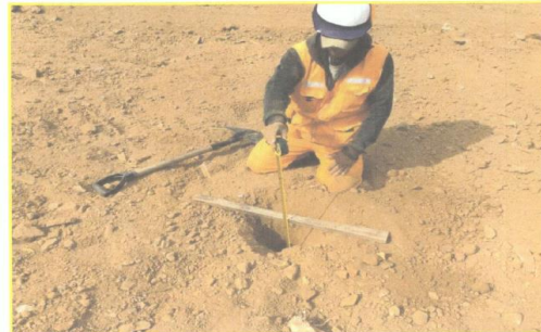
Foto 58. Calicata verificando el espesor de top soil.
