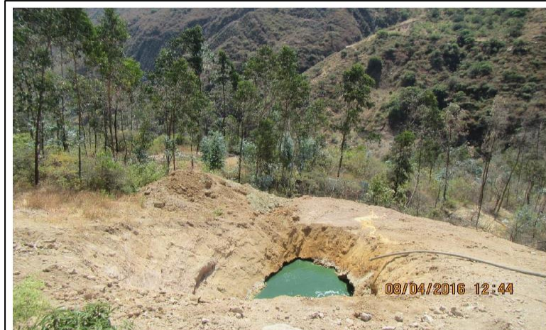
Fotografía N° 154: Vista panorámica del punto de muestreo ESP-2 - Agua de la poza de tratamiento manual del subdrenaje de la relavera Higospampa, que descarga a la poza de tierra, con coordenadas (UTM WGS-84), E 777022 N 9160597.
