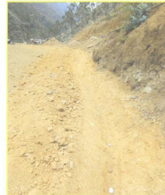
Foto 64. En la vista se aprecia la conformación de cunetas.
