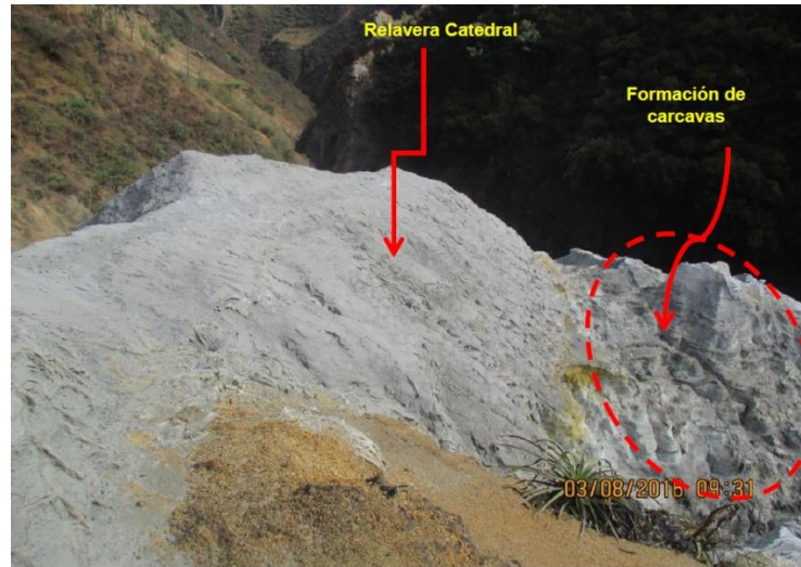
Fotografía N° 81: Otra vista de la relavera Catedral, ubicada en coordenadas UTM (WGS 84), E: 778496 N: 9160250. Se observa el relave expuesto a la intemperie y sin ningún tipo de cobertura. No se han realizado las actividades de cierre.
