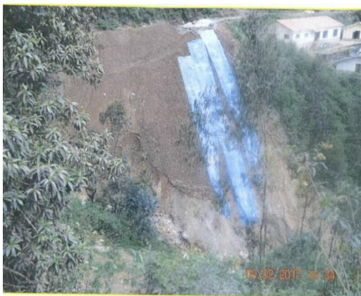
Cobertura de los taludes de la desmontera frente a fuerte precipitaciones pluviales.
