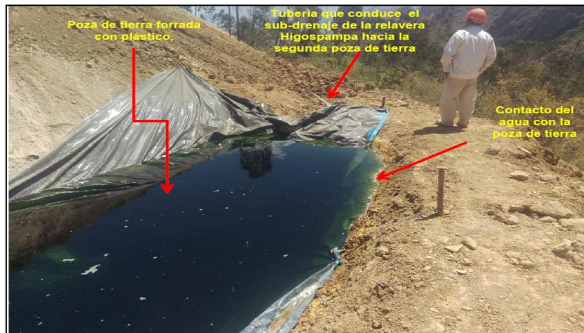
Fotografía N° 63: Vista de un sector de la poza de tierra, donde se observa que el forro no cubre totalmente la poza, estando el agua en contacto con el suelo.
