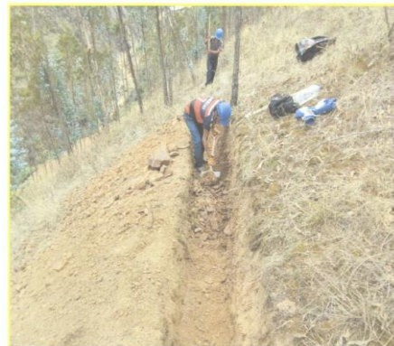
Foto 63. Conformación de canal de coronación, en la vista se observa el corte del terreno.
