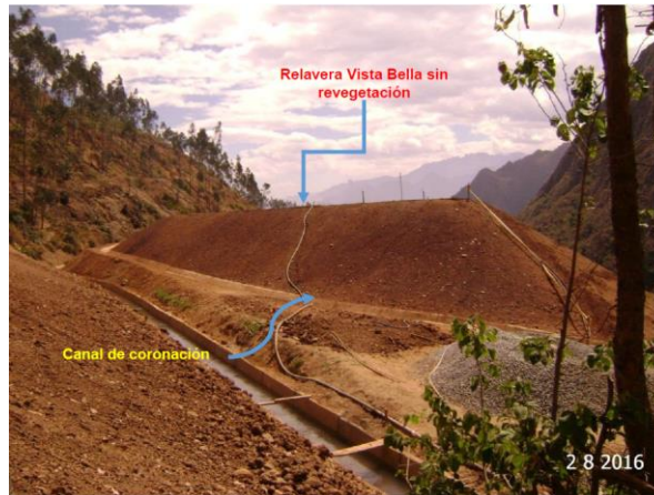
Fotografía N° 22: Vista de la Relavera Vista Bella, ubicada en coordenadas UTM (WGS 84), E: 778947 N: 9160030, su superficie se encuentra cubierto de top soil, cuenta canal de perimetral de concreto.
