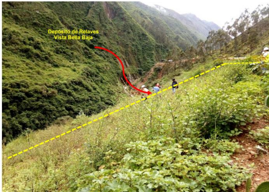
Fotografía N° 1: Vista de perfil del depósito de relaves Vista Bella Baja
