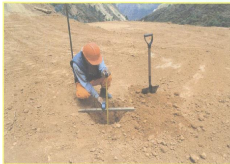
Foto 49. Vista donde se observa el control de espesor de top soil.
