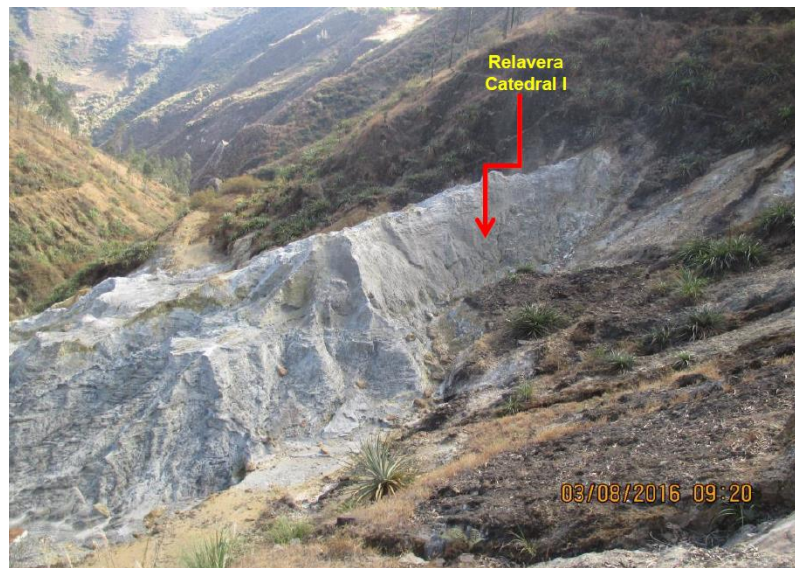
Fotografía N° 83: Otra vista de la relavera Catedral I, ubicada en coordenadas UTM (WGS 84), E: 778500 N: 9160027, donde se observa el relave expuesto a la intemperie y sin ningún tipo de cobertura. No se ha realizado actividades de cierre.
