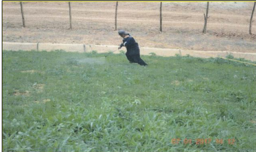
Aplicación de enraizador en el talud inferior de la relavera.
