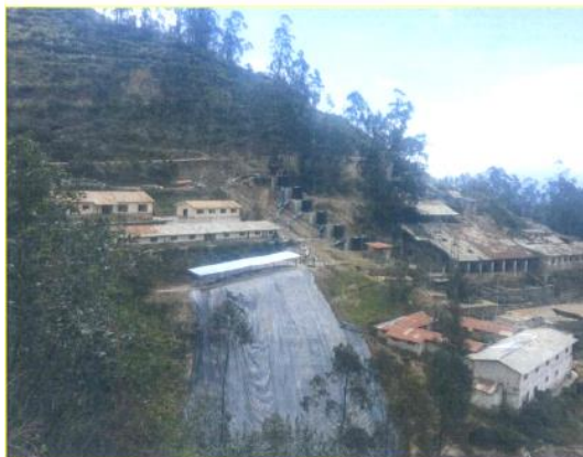
COBERTURA DE TAD DE LA DESMONTERA ESPERANZA
