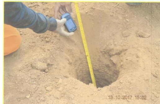
Foto 35. Control del espesor de arcilla con su ubicación de calicata con respectivas coordenadas.
