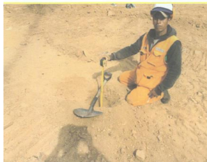
Foto 38. Control de espesor de top soil en relavera Catedral I.
