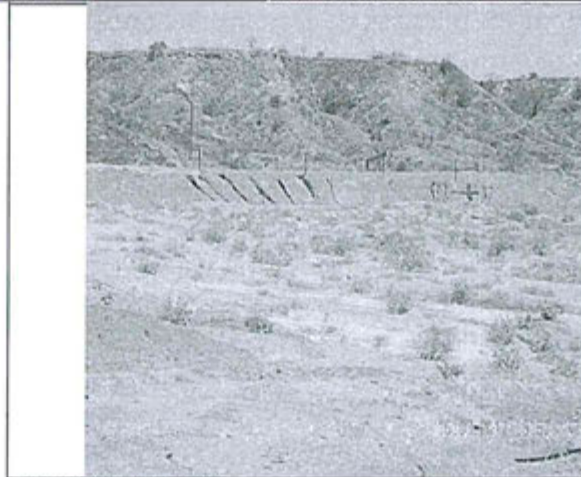
Fotografía N° 3: Poza de Detritos - Itallena 24. Se observan taludes erosionados. Presencia de sedimentos en superficie interna de poza por arrastre de aguas de lluvias. Coordenadas UTM - WGS 84 (Zona 17): 471913E, 9520970N, 229 m.s.n.m.
