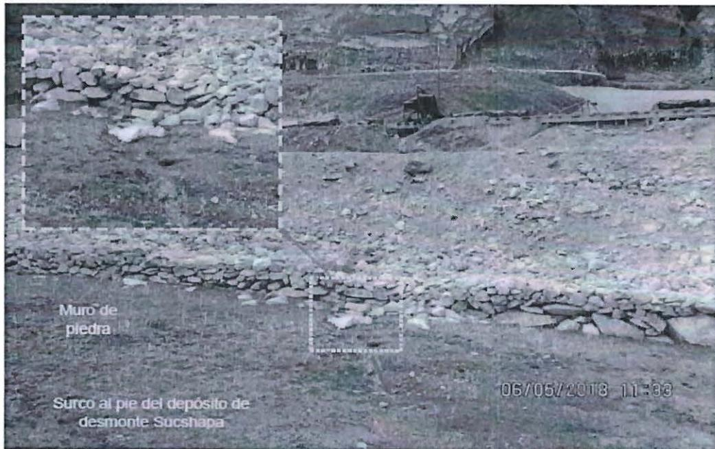
Fotografía N° 5: Se aprecia uno de los surcos (sin flujo de agua) generados por erosión hídrica.
