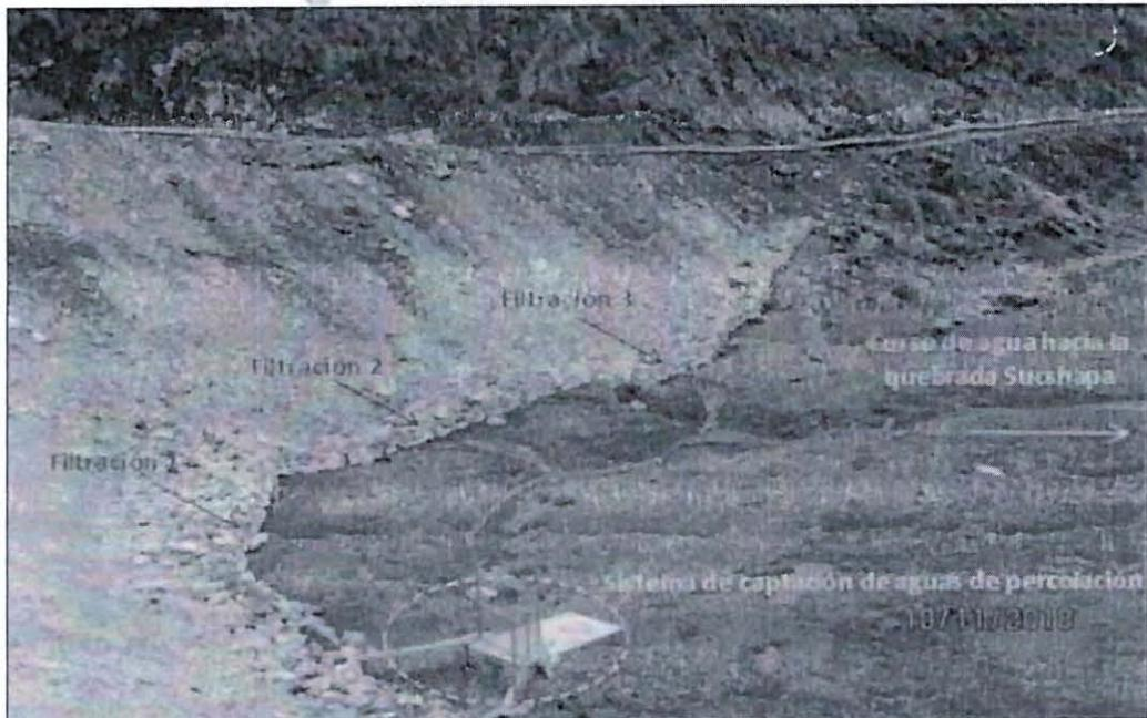
Fotografía N° 9: Se aprecia tres flujos de agua al pie del depósito de desmonte Sucshapa, los cuales discurren por el bofedal hacia la laguna Rupahuay.
