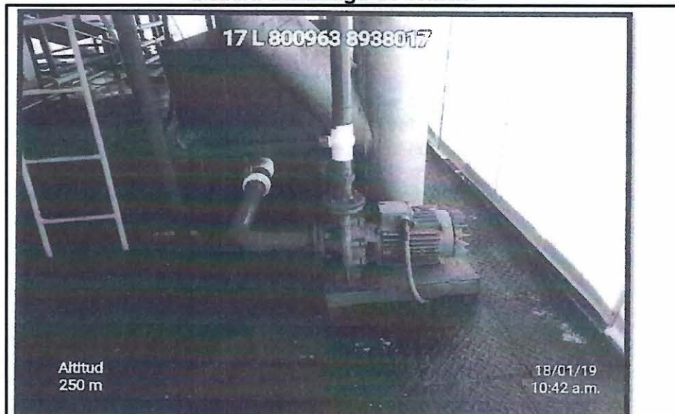
Foto N° 2. Bomba centrífuga de 10 m 3 /h para el tratamiento de los efluentes de proceso (sanguaza y caldo de cocción).
