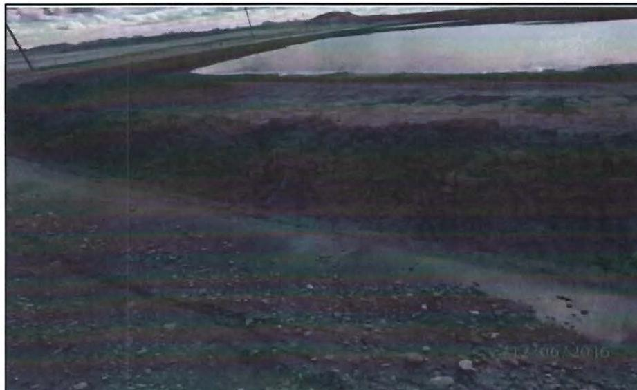
**Fotografía N° 66. Hallazgo N° 8.-** Vista cercana en la que no se aprecia que se tenga el borde libre de un metro entre el nivel del relave y la cresta del dique, también se observa el espejo de agua de dicha relavera
