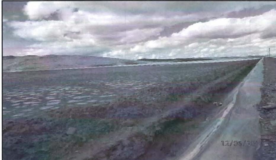
**Fotografía N° 65. Hallazgo N° 8.-** En el depósito de relaves N° 7 que no existe borde libre de un metro entre el nivel de relave acumulado y la cresta del dique encontraba pegado al dique.
