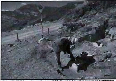
Fotografía N° 122: Incumplimiento N° 01: Otra Vista fotográfica del área de la plataforma PLT-23, donde se observa tres sondejos de los ocho verificados los cuales no presentaban afloramiento de agua.
