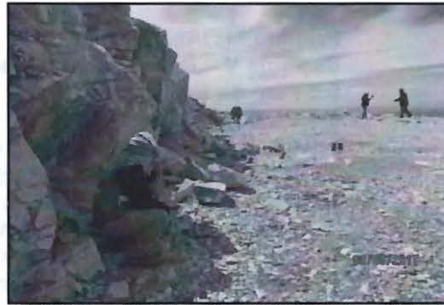
Fotografía N° 51: Incumplimiento N° 01 y 02: Otra Vista fotográfica del área de la plataforma SC-07, en donde se realizó la medición de los lados (ancho y largo).
