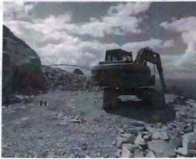
Foto 30: Plataforma de perforación SC-07, en proceso de retomar el material removido hacia el talud de la plataforma; haciendo uso de una excavadora
