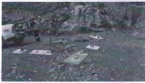
Foto 22: Plataforma PLT-22, antes (10 sondajes ejecutados)
