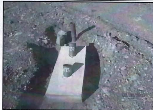
Fotografía N° 156: Incumplimiento N° 01: Vista fotográfica de la Plataforma de Perforación PLT-20, donde se observó los sondajes con código AT 137 y AT 138; los cuales presentaba un bloque de concreto y una tubería de PVC.
