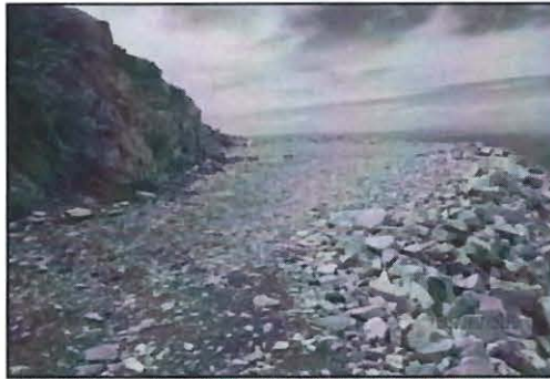
Fotografía N° 50: Incumplimiento N° 01 y 02: Vista fotográfica del área de la plataforma SC-07, donde se observó el corte del talud realizado en el terreno, se verificó como sondejos los cuales no presentaban almacenamiento de agua.
