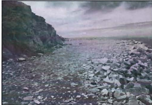
Fotografía N° 60: Incumplimiento N° 01 y 02: Vista fotográfica del área de la plataforma SC-07, donde se observó el corte del talud realizado en el terreno, se verificó cinco sondajes los cuales no presentaban afloramiento de agua.
