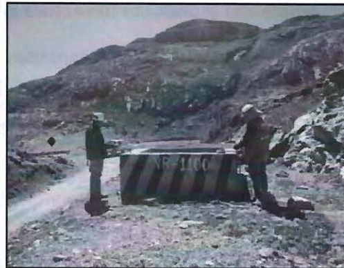
Fotografía N° 141: Incumplimiento N° 03: Otra Vista fotográfica del área de la chimenea VR-1100, donde se realizó la medición de la estructura que protege la chimenea, también se realizó la medición del diámetro de la chimenea.
