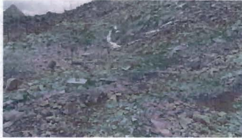
Foto 12: Plataforma PLT-3, después (queda 1 sondaje)
