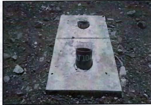
Fotografía N° 130: Incumplimiento N° 01: Otra Vista fotográfica del área de la plataforma PLT-22, donde se observa dos sondejos de los diez verificados, dichos sondejos no presentaban afloramiento de agua.
