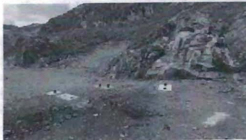
Foto 24: Plataforma PLT-22, después (quedan 7 sondajes)
