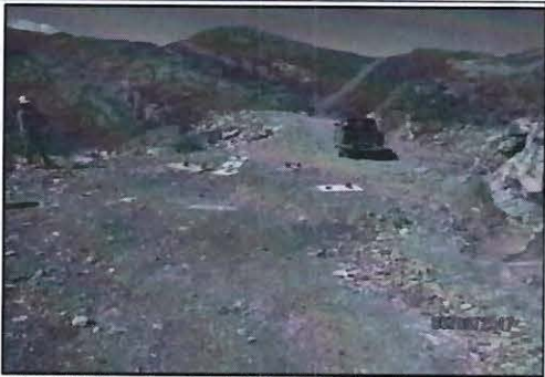
Fotografía N° 127: Incumplimiento N° 01: Vista fotográfica del área de la plataforma PLT-22, donde se observó que el área de la plataforma se encontraba formando parte del acceso, se verificó diez sondajes.
