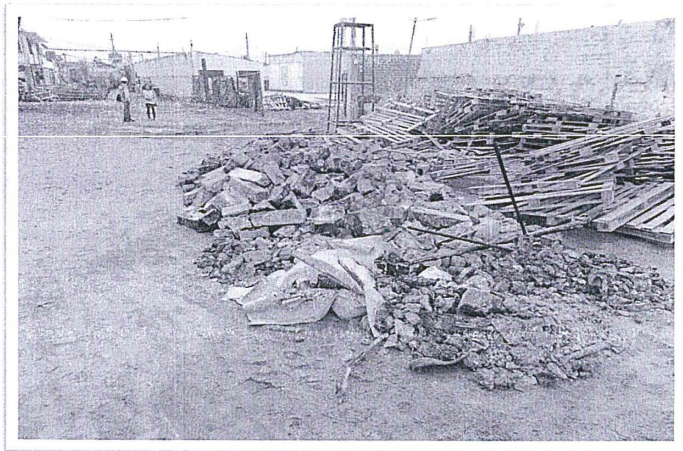
Fuente: Fotografía correspondiente a la supervisión realizada el 26 de mayo de 2017.
