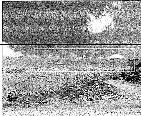
**Fotografía N° 59.** Botadero de desmonte 3, tiene 10 bancos de 10 metros de altura y 15 hectáreas de área aproximadamente. COORDENADAS UTM WGS84: 8829828N, 366852E. ZONA 18. Hallazgo N° 02.
