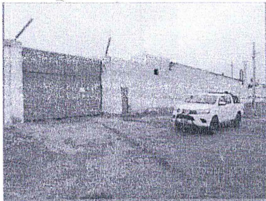
Foto N° 24: Puerta de ingreso a la unidad fiscalizable ubicada en el Pasaje Santa Rosa s/n
