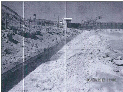
Fotografía N° 88. En la imagen se observa el canal de colección ubicado adyacente al depósito de relave. COORDENADAS UTM WGS84: 8378622N, 700264E. ZONA 18
