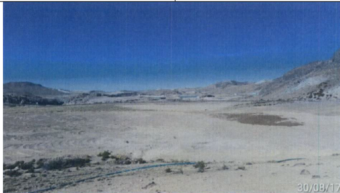
Fotografía 5. Poza de Sedimentación después del retiro del muro de tierra y nivelación. Coordenadas UTM WGS84 8379616N, 701270E
