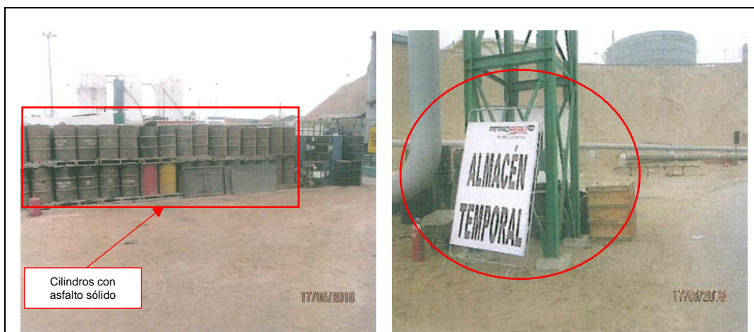
Cuadro N° 2: Fotografías N° 7 y 8 del Informe de Supervisión
