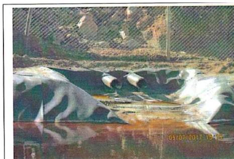
Fotografía N° 124: Poza de monitoreo de subdrenajes del sistema de tratamiento pasivo – wetland, la misma que estaría evacuando un efluente a la quebrada Auqueato.
