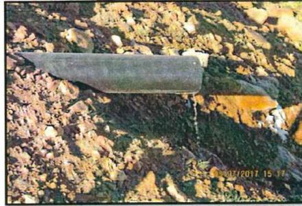
Fotografía N° 126: Tubería de HDPE de 6 pulgadas de diámetro que descarga hacia la quebrada Auqueato el efluente de la poza de monitoreo de subdrenajes del sistema de tratamiento pasivo – wetland, con un pH de 2.82, Temp. = 14.8 °C, una conductividad de 6300  $\mu$ S/cm y caudal = 0.028 L/s, conforme a la muestra tomada con código ESP-6, el cual no se encontraría contemplado en un Instrumento de Gestión Ambiental.
