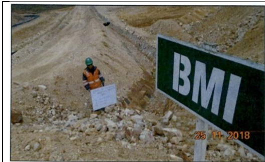
Foto 2.1. Vista mostrando el inicio del canal de mampostería de la parte sureste del BMI (zona correspondiente a la ampliación), este canal conduce las aguas de contacto del cuerpo del BMI así como lo proveniente de la Cantera Willy II. Se tiene las coordenadas siguientes: N 8°610,983 y E 437,452.
