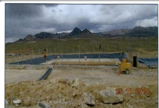
Foto 2.4. Vista mostrando la Poza de Colección del BMI, en esta poza se colecta las aguas de contacto provenientes de la ampliación del BMI y Cantera Willy II.
