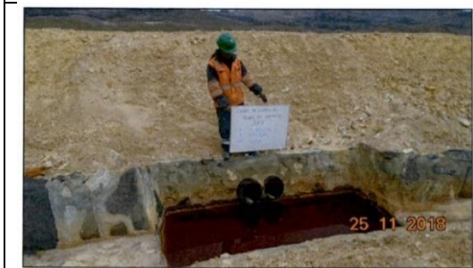
Foto 2.3. Vista mostrando la poza de captación y desvío de las aguas de contacto a la Poza de Colección del BMI. Las aguas provienen de las zonas norte y sur de la ampliación del BMI, así como también de la Cantera Willy II. Se tiene las coordenadas siguientes: N 8°611,055 y E 437,126.
