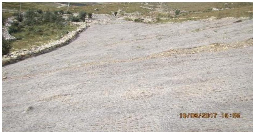
Fotografía N° 59. Vista del acceso a las plataformas PL-YAN-12-282 y PL-YAN-12-301, el cual se encontraba rellenado y perfilado de acuerdo al entorno topográfico del lugar, el talud se encontraba revestido con biomanta de fibra de coco; sin embargo, no presentaba vegetación (Coordenadas UTM WGS 84 Zona 17 E 775 460 N 9 225 652).
