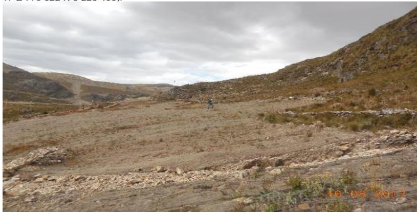
Fotografía N° 34. Vista del área de la plataforma PL-YAN-12-298, la cual se encontraba perfilada de acuerdo al entorno topográfico del lugar y revestida con biomanta de fibra de coco, pero sin presencia de vegetación. Asimismo, en la parte superior se observaron canales de coronación excavado en tierra. No se observaron afloramientos de agua (Coordenadas UTM WGS 84 Zona 17 E 775 449 N 9 225 500).
