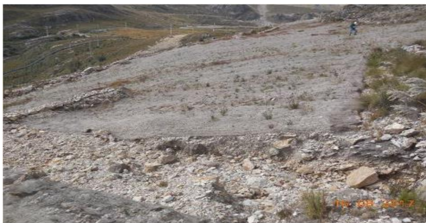
Fotografía N° 58. Vista del acceso a la plataforma PL-YAN-12-298, el cual se encontraba rellenado y perfilado de acuerdo al entorno topográfico del lugar, el talud se encontraba revestido con biomanta de fibras de coco; sin embargo, no presentaba vegetación. (Coordenadas UTM WGS 84 Zona 17 E 775 502 N 9 225 587).
