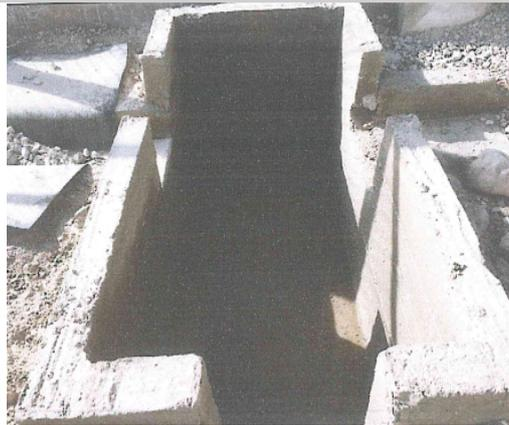
Fotografía N° 8: Instalación de poza de colección de efluentes.
