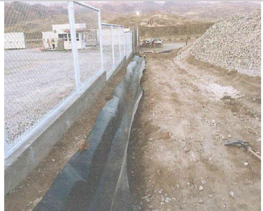
Fotografía N° 10: Instalación de Geomenbrana para drenaje Frances.
