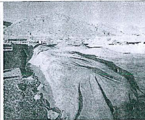
Foto N° 07: Cajas de logueo cubiertas con geomebrana
