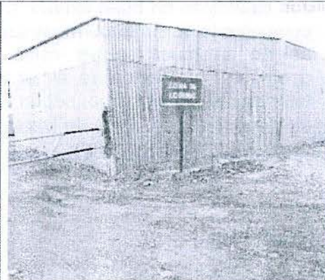
Foto N° 06: Calaminas reparadas y repuestas
