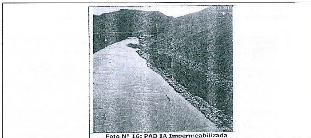
Foto N° 16: PAD IA Impermeabilizada
