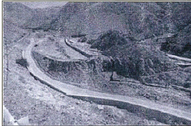
Figura 5.1 – Antes de la ejecución de obras
