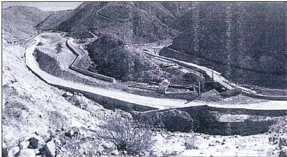
Figura 5.2 – Muro enrocado habilitado próximo a la unión de las quebradas Cimarrona e Incapuquio
