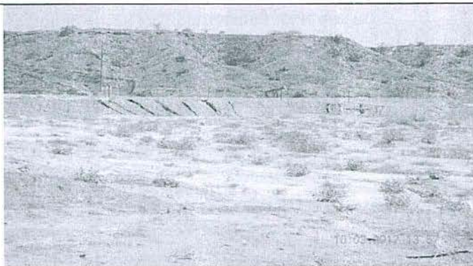
Fotografía N° 3: Poza de Detritos – Ballena 24.
