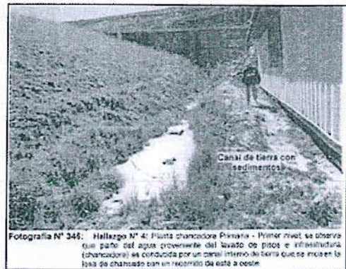
Fotografía N° 345: Hallazgo N° 4: Planta chancadora Primaria - Primer nivel, se observa que parte del agua proveniente del lavado de pisos e infraestructura (chancadora) es conducida por un canal interno de tierra que se inicia en la losa de chancado con un recorrido de este a oeste.
