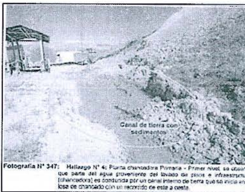
Fotografía N° 345: Hallazgo N° 4: Planta chancadora Primaria - Primer nivel, se observa que parte del agua proveniente del lavado de pisos e infraestructura (chancadora) es conducida por un canal interno de tierra que se inicia en la losa de chancado con un recorrido de este a oeste.
