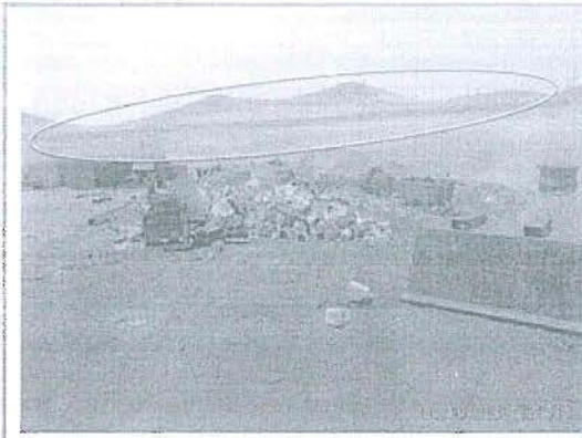
Foto N° 19: Imagen que muestra el área de acopio de residuos peligrosos, la misma que se encuentra ubicado al lado suroeste de la planta, al pie de un cerro arena. Esta área no se encuentra cercada, cerrada, techada, impermeabilizado ni señalizada.
