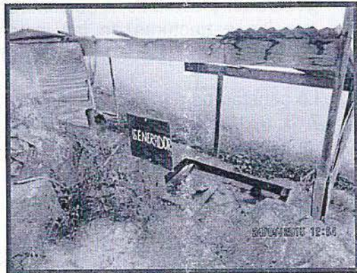
Fotografía N° 17: Vista panorámica de la plataforma de un componente del proyecto de exploración denominado Generador.
