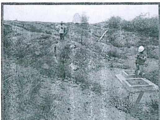
Fotografía N° 8: Georeferenciación y verificación de los pozos sépticos de la zona de campamento.
