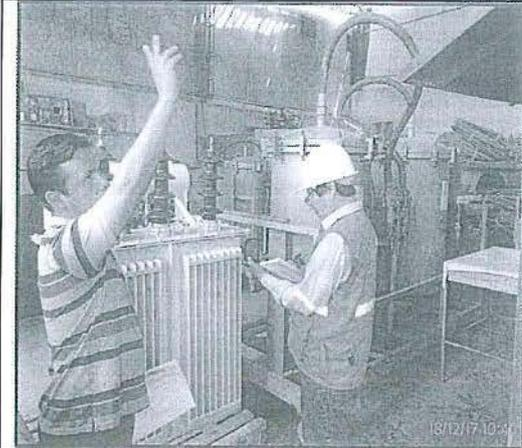
Fotografía N° 5: Vista de transformadores de distribución de energía de 500 KVA, alquilados por el administrado en las instalaciones de sus clientes. Los equipos se encuentran sobre parihuelas de madera, piso de cemento y área techada.
