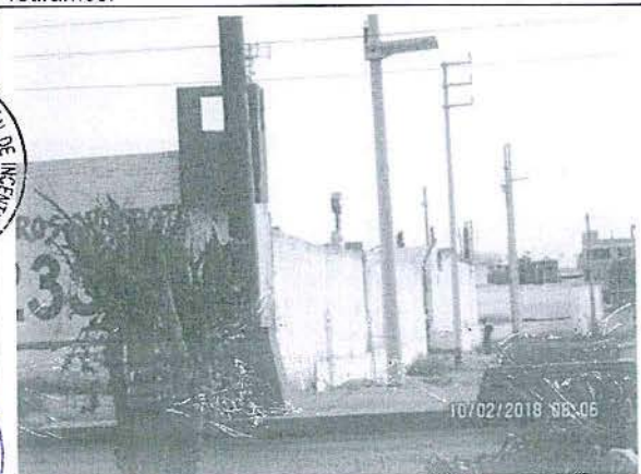
Foto N° 07.- Frontis del EIP PESQUERA GAMMA SA. - PLANTA CHIMBOTE (Avenida Meiggs). Se puede apreciar que un personal del establecimiento industrial intentando ingresar a planta.
