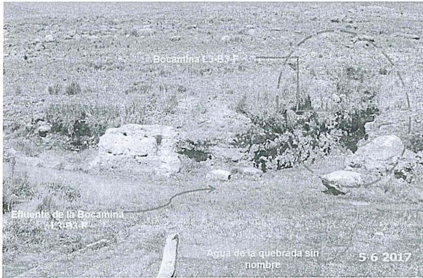
Fotografía N° 5: Otra vista de la bocamina L3-B3-F ubicada en coordenadas UTM (WGS 84), E: 227895 N: 8915140, se observa vegetación a su alrededor y el efluente con sólidos de color naranja que sale de esta bocamina, y se junta con el agua de la quebrada sin nombre.
