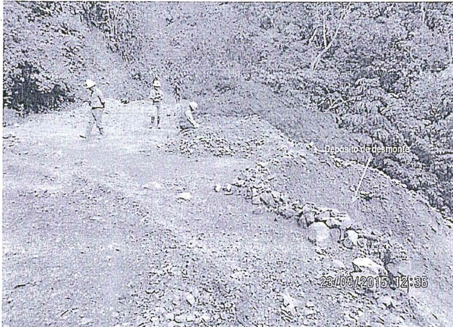
Fotografía N° 81.- Se constató la existencia de otra área – en la zona de Arcopunco – donde se ha colocado material proveniente del interior mina (desmonte), coordenadas UTM datum WGS 84: 457 086 E, 8 761 332 N y 1 749 msnm. Este depósito de desmonte no cuenta con estructuras hidráulicas para el manejo de la escorrentía o pluviometría de la zona.
