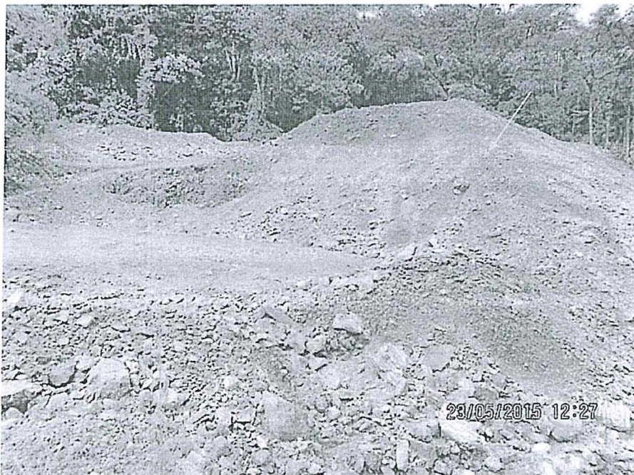
Fotografía N° 70.- Se constató la existencia de un área – en la zona de Arcopunco – donde se ha colocado material proveniente del interior mina (desmonte), coordenadas UTM datum WGS 84: 457 055 E, 8 761 452 N y 1 764 msnm. Se aprecia el talud del depósito de desmonte.
