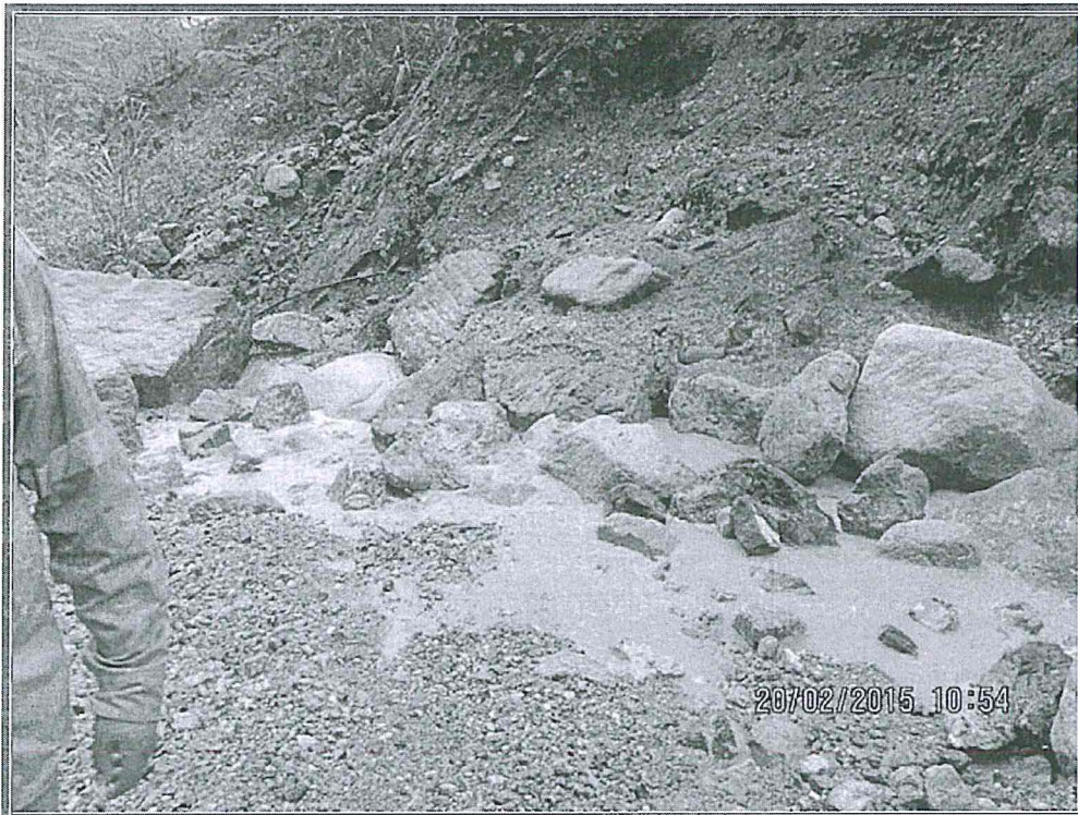
Fotografía N° 42: Se observa deslizamientos de relave hacia el cauce del río Puntayacu debido a la falta de defensa ribereña en el talud de la relavera R1 y R2.
