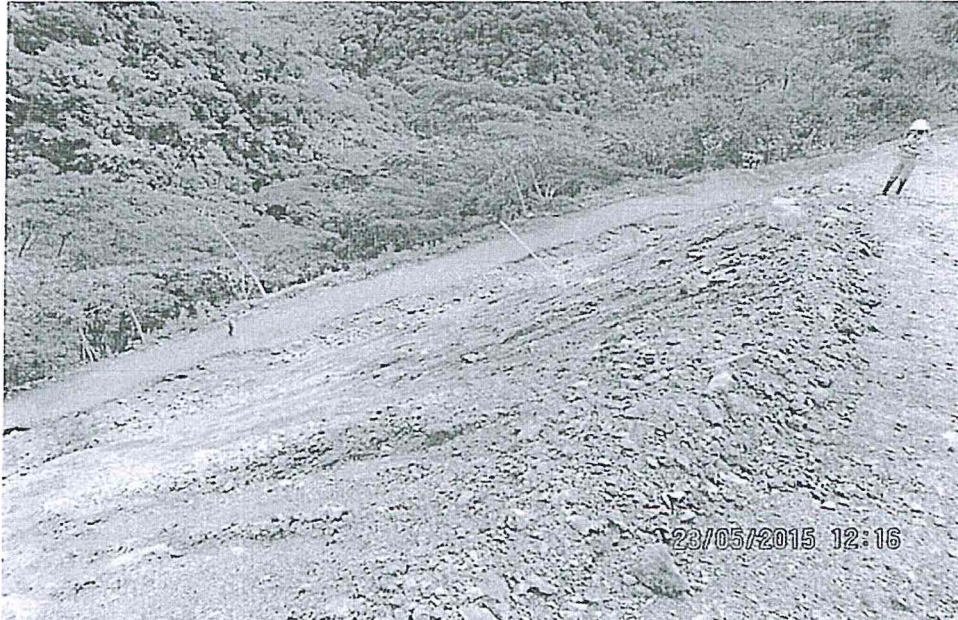
Fotografía N° 67.- Se constató la existencia de un área – en la zona de Arcopunco – donde se ha colocado material proveniente del interior mina (desmonte), coordenadas UTM datum WGS 84: 457 055 E, 8 761 452 N y 1 764 msnm. Este depósito de desmonte no cuenta con estructuras hidráulicas para el manejo de la escorrentía o pluviometría de la zona.
