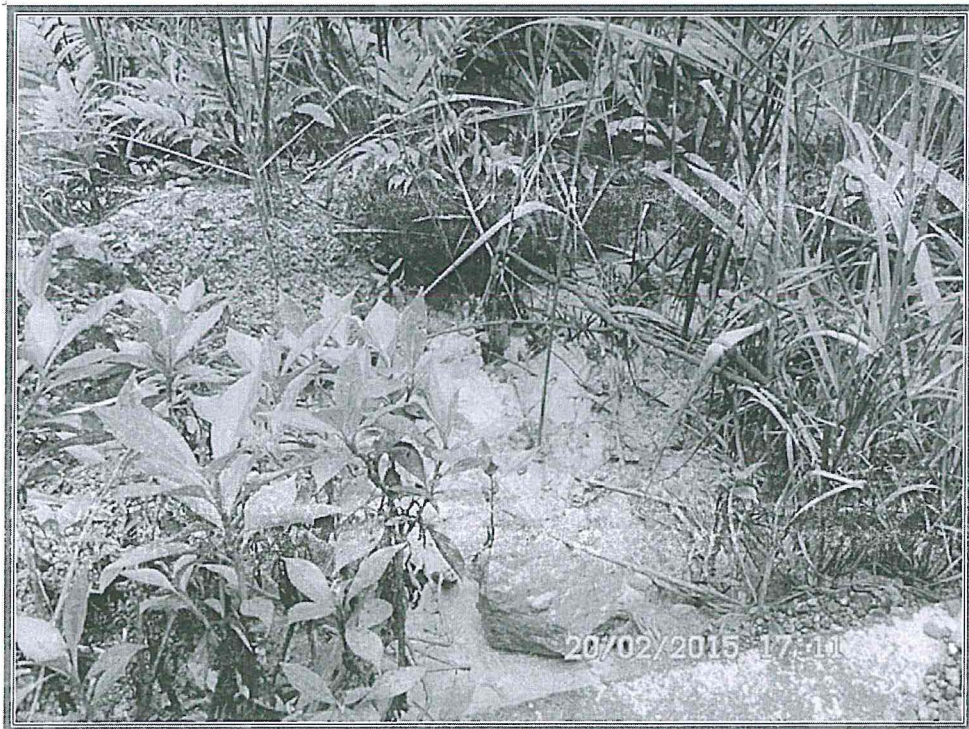
Fotografía N° 96: Flujo de agua del interior de la Bocamina San Judas, Nivel 1630. Vista de la descarga del flujo de agua proveniente del interior de la bocamina San Judas Nivel 1630 hacia el curso natural de agua – Talud de la margen derecha de la quebrada y río Puntayacu.
