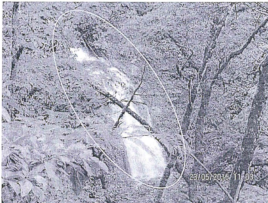
Fotografía N° 33.- Descarga o vertimiento sin previo tratamiento de agua proveniente del interior de mina, Nv. 1455, a través del túnel de drenaje del 1455 hacia la quebrada Puntayacu.
