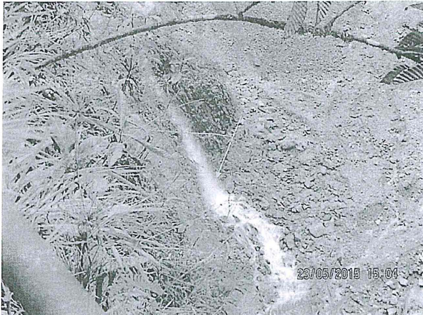
Fotografía N° 49.- Descarga o vertimiento sin previo tratamiento de agua proveniente del interior de mina, Nv. 1570, a través del túnel de drenaje del 1455 hacia la quebrada Puntayacu.
