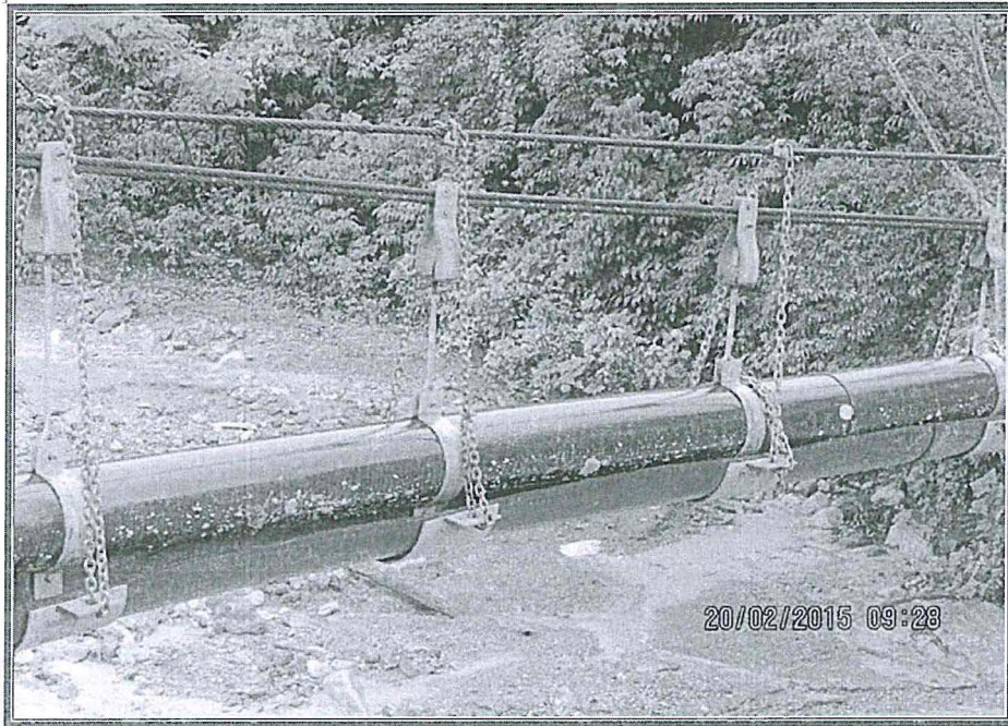
Fotografía N° 33: Línea de conducción de relaves desde la planta concentradora San Vicente hacia depósito de relaves La Esperanza. Vista de la línea de conducción de relaves que en forma aérea, cruza al río Puntayacu en su recorrido hacia el depósito de relaves La Esperanza. Se constató que la tubería de conducción de relaves no cuenta con el sistema de contención de posibles derrames y/o fugas de relaves. Como detalle se observa que la tubería en la parte inferior tiene adherido una protección de material HDPE.
