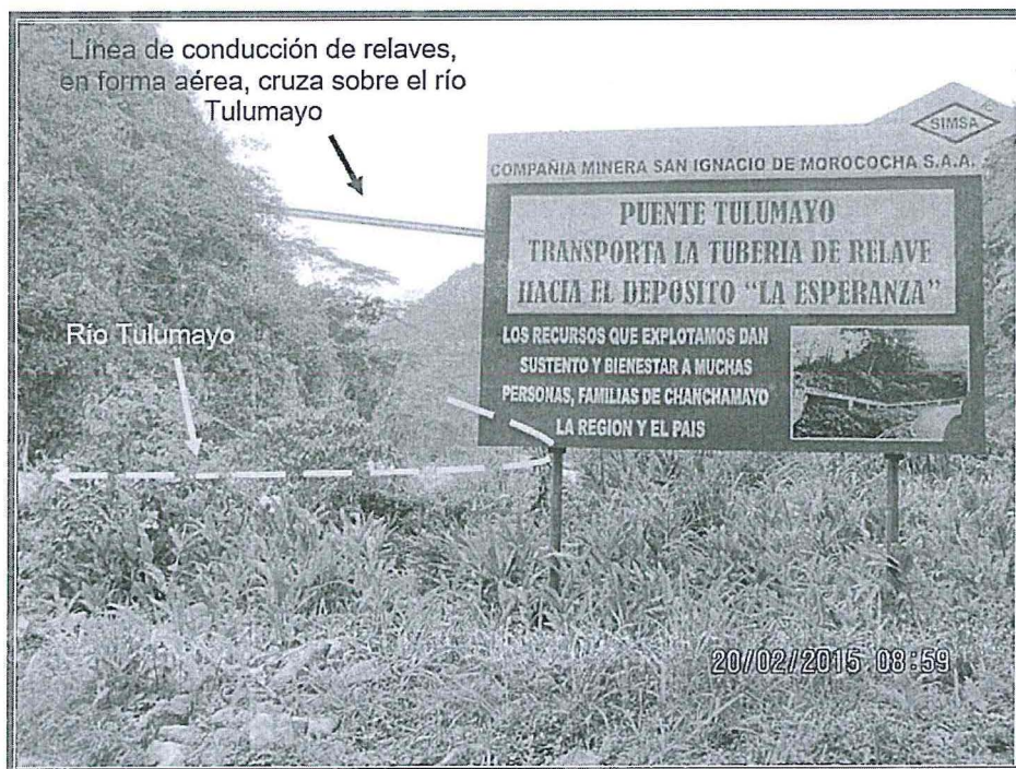
Fotografía N o 26: Línea de conducción de relaves desde la planta concentradora San Vicente hacia depósito de relaves La Esperanza. Vista de la línea de conducción de relaves que en forma aérea, cruza al río Tulumayo en su recorrido hacia el depósito de relaves La Esperanza.
