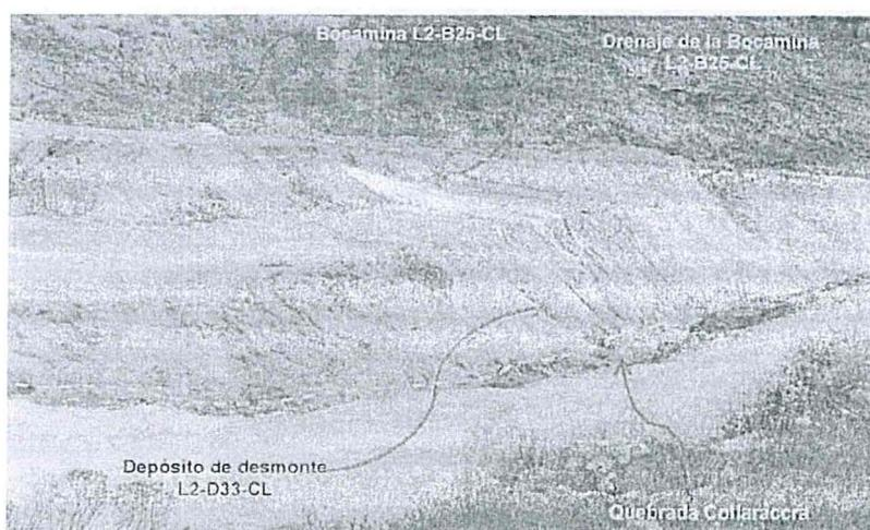
Fotografía N° 99: Vista panorámica de la bocamina L2-B25-CL, cuyo drenaje discurre por la plataforma superior del depósito de desmonte L2-D33-CL para luego descargar a la quebrada Collaracra.
