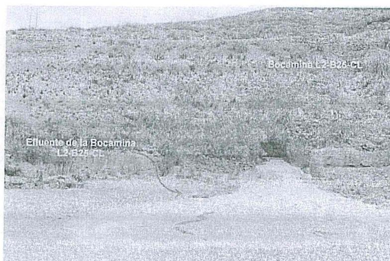
Fotografía N° 93: Vista panorámica de la bocamina L2-B25-CL, ubicada en coordenadas UTM (WGS 84), E. 227285 N: 6913549, el portal se encuentra abierto, en su entorno superior se observa vegetación, y en el inferior material propio del depósito de desmonte L2-D33-CL, por donde fluye el efluente de color blanquecino.
