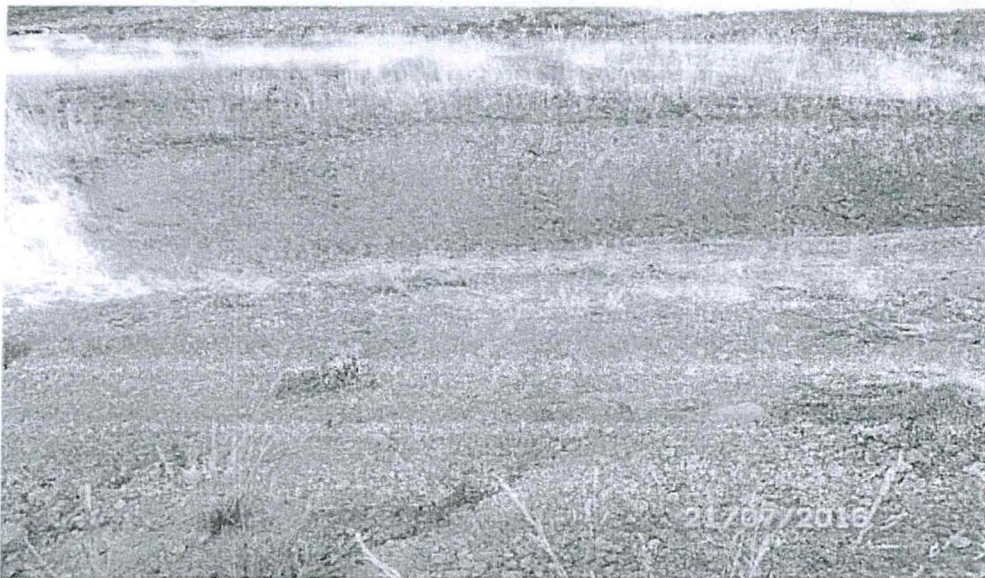
Fotografía I2e-4. Movimiento de terreno para la construcción del acceso vehicular hacia la torre T-50, la construcción de este camino no está contemplado en el IGA del proyecto.
