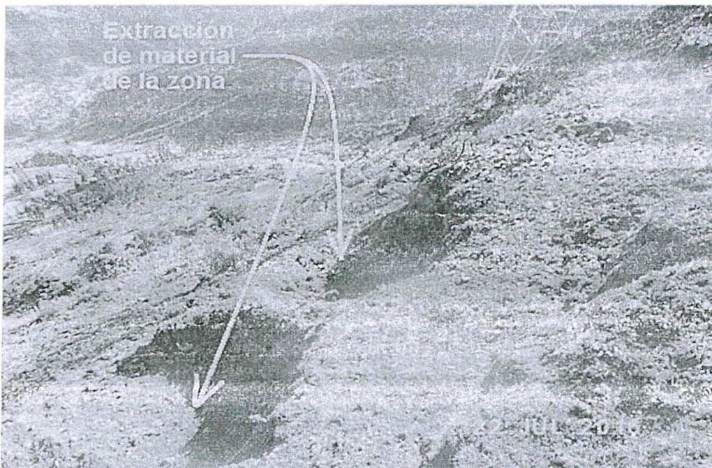
Fotografía I2d-1. Extracciones de material tierra en dos zonas cercanas a la torre T-47.
