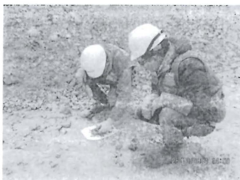
Fotografía N° 113: Hallazgo N° 02. Vista del personal de monitoreo realizando la proporcionalidad de finos y gruesos que presenta dicho desmonte.
