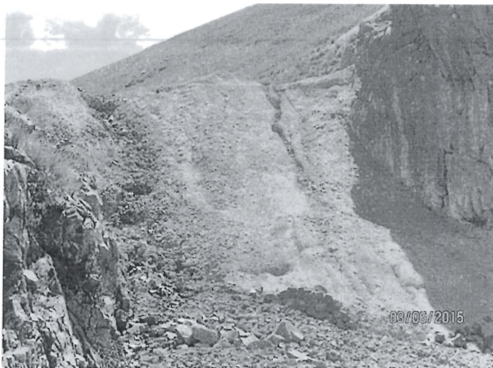
Fotografía N° 8: Depósito de desmonte pendiente de cierre, ubicado en las coordenadas UTM WGS 84 N 8918635 y E 226263.
