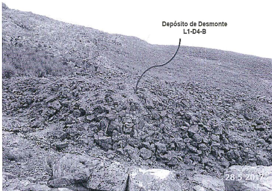
Fotografía N° 52: Otra vista panorámica del depósito de desmonte L1-D4-B, ubicado en coordenadas UTM (WGS 84), E: 222086 N: 8923277, se observa material de desmonte expuesto al ambiente, y escasa vegetación por uno de sus bordes.
