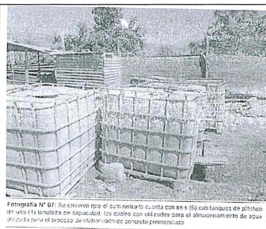
**Fotografía N° 07:** Se observa que el administrador cuenta con seis (6) cubitanques de plástico de una (1) botellera de capacidad, los cuales son utilizados para el almacenamiento de agua utilizada para el proceso de elaboración de concreto premezclado
