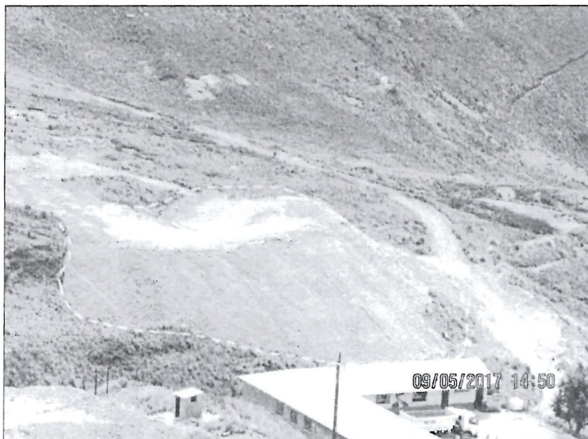
Fotografía N° 76.- Vista del depósito de material de desbroce, ubicado en las coordenadas UTM Datum WGS 84 424334E y 8640296 N, se verificó que contaba con un área aproximada de 1700 m 2
