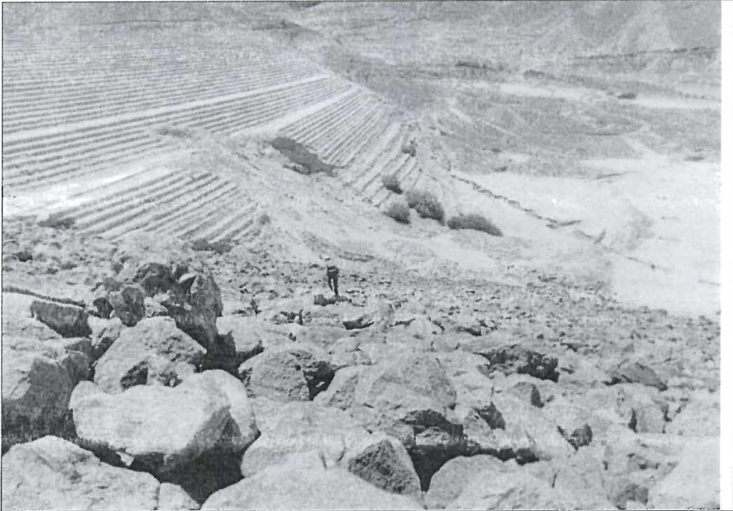
Fotografía N° 45. Parte media del depósito de relaves de flotación se erosionado por acción del agua de escorrentía que habría ingresado a dicho depósito, hecho que se habría producido por la falta de mantenimiento del canal de coronación. Forma parte del presunto incumplimiento N° 2.
