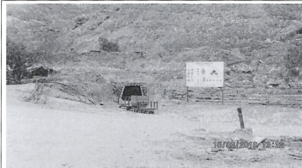
Fotografía N° 2 Bocamina B-56 (Mina Vieja) : Se encuentra abierta, no existiendo salida de agua desde su interior. No se observó que se tenga implementado cerco de alambre con columna de madera, tampoco se observó zanjas de coronación. Por versión del administrado, esta bocamina ha sido abierta por mineros informales, los que actualmente vienen desarrollando actividades en su interior. Forma parte del presunto incumplimiento N° 1.
