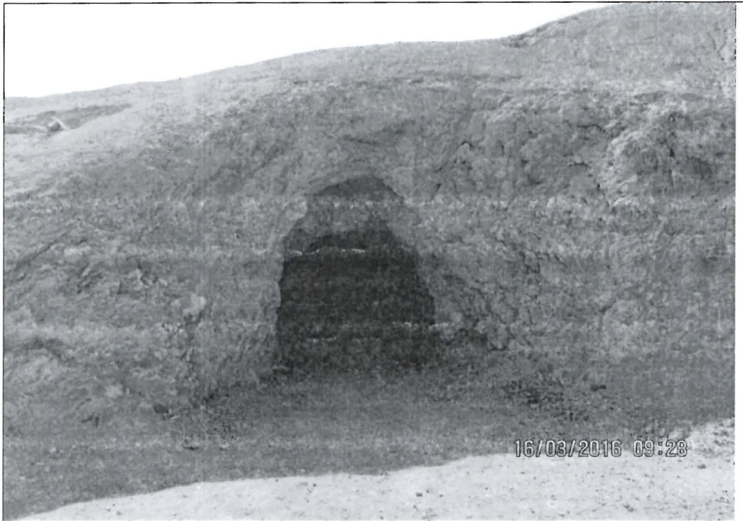
Fotografía N° 33 Bocamina B-84 (Tunel Santa Rosa) : Vista del ingreso a la bocamina, no se observó salida de agua desde su interior. no se observó que se tenga implementado cerco de alambre con columna de madera, tampoco se observó zanjas de coronación. Forma parte del presunto incumplimiento N° 1.
