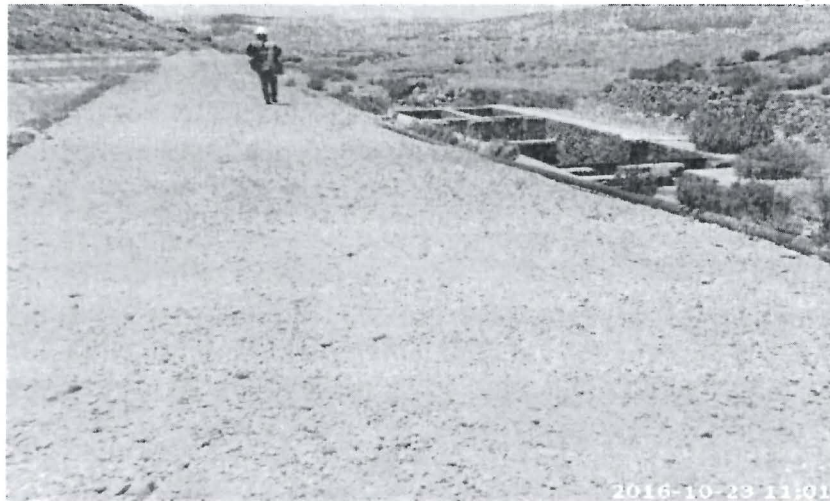
Fotografía N° 125: Hallazgo N°1: El sistema de tratamiento de agua proveniente de la bocamina B-10 ha sido construido sobre el Depósito de desmonte DD-04 (Antigua escombrera E-8). Así mismo, dentro del área de dicho depósito se encuentra una estructura de concreto y una poza de concreto.
