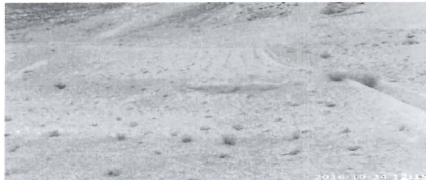
Fotografía N° 157: Hallazgo N°5: Se observó crecimiento de vegetación característica de la zona, creciendo al interior del canal de coronación de la escombrera E-10.
