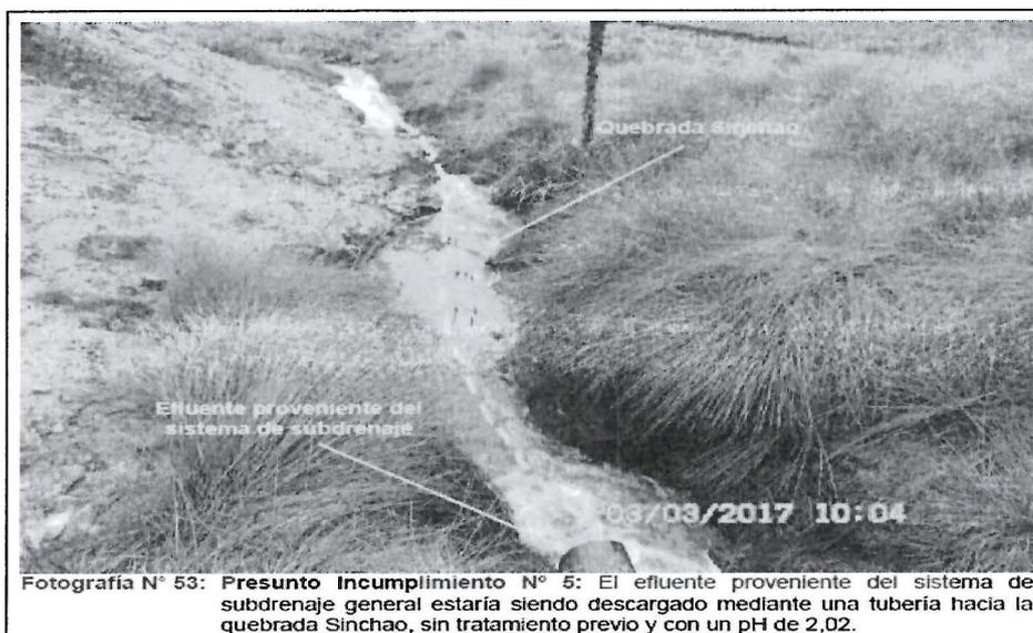
Fotografía N° 53: Presunto incumplimiento N° 5: El efluente proveniente del sistema de subdrenaje general estaría siendo descargado mediante una tubería hacia la quebrada Sinchao, sin tratamiento previo y con un pH de 2,02.
